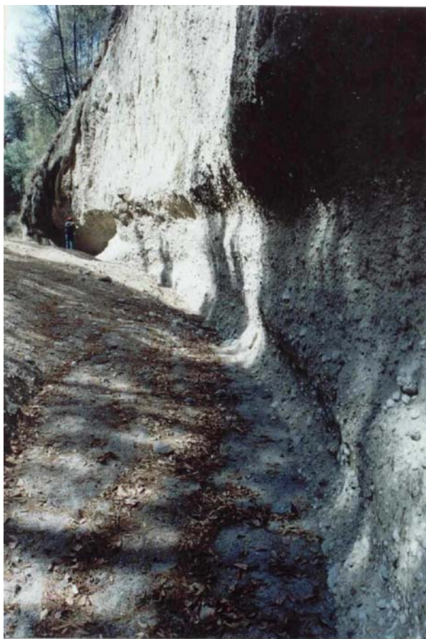
Figura 3.10 Barranco Tenejac Sección Media. La erosión lateral ha socavado paulatinamente sus paredes.
