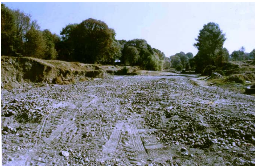
Figura 3.4 Barranco Atlapitz Sección Media. El cauce se encuentra alterado en cuanto a su dinámica natural debido a que es una brecha por la que circulan vehículos que transportan material (arena y bloques).
