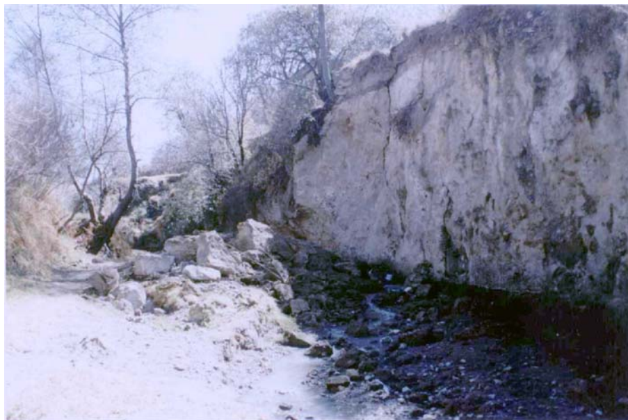
Figura 3.2 Barranco Atlapexco Sección Baja. En las paredes, es evidente el desprendimiento de material debido a la erosión lateral del río.
