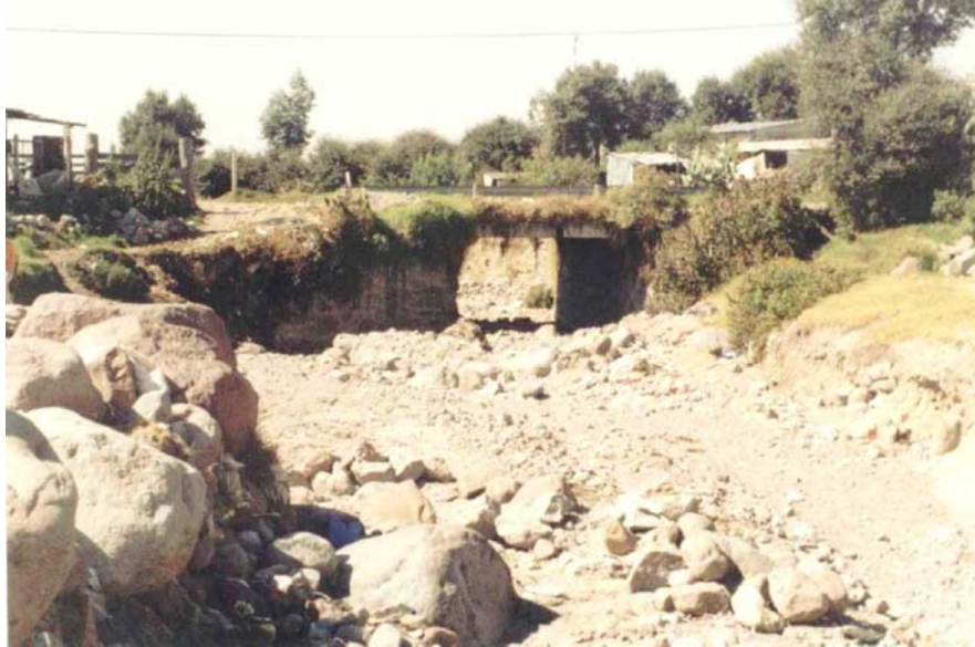
Figura 3.20 Barranco Xalpatlaco Sección Media. Según testimonios de la población local, el puente se bloquea debido a la acumulación de bloques durante las crecidas y se inundan las viviendas.
