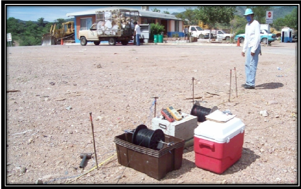
Instalación del Equipo de Exploración Geoeléctrica para Realizar el SEV-1.
