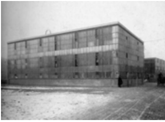
Fig. 31 Fotografía del muro-cortina de uno de los edificios de la fábrica Margarethe Sétif, proyecto atribuido a Richard Sétif Giengen, 1903 Fuente: GÖSSEL, Peter, Arquitectura del siglo XX , Alemania, KÖLN BENEDIKT TASCHEN, 1991 p: 99
