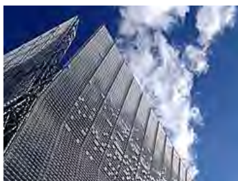
Fig. 46 Discursos cinéticos inscritos las superficies del Centro Suizo de las Ciencias en Winterthur con la superficie Technorama facade (arriba) y en el Museo del niño de Pittsburg con Articulated cloud (abajo). Fenomenologías resultadas de las corrientes de viento que golpean las miles de placas metálicas dispuestas sobre la totalidad de las estructuras semitranslúcidas. Winterthur, 2002 / Pittsburg, 2004 Fuente: http://nedkahn.com
