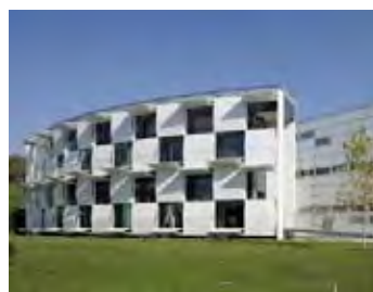
Fig. 65 Imágenes del trabajo electromecánico de los paneles de aluminio que colman la fachada del edificio Kiefer Technic office Graz, 2007 Fuente: www.e-architect.uk keyword: eine fassade tanzt
