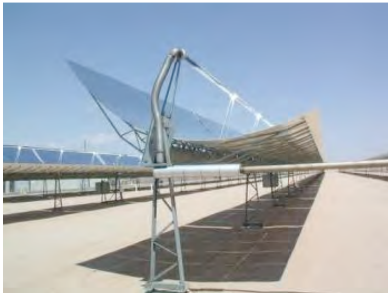
Figura 27. Estructura de un captador LUZ LS-3 (RenewablEnergyWorld,2009)
