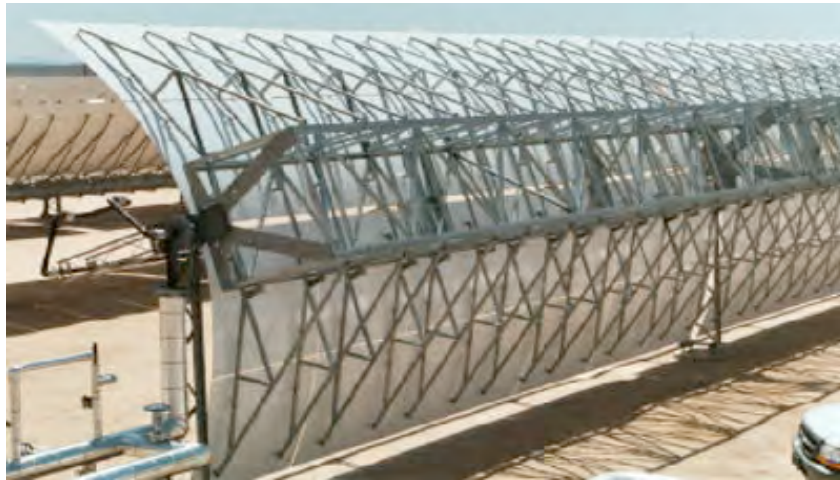
Figura 28, Estructura de un captador EuroTrough (BMU, 2009)
