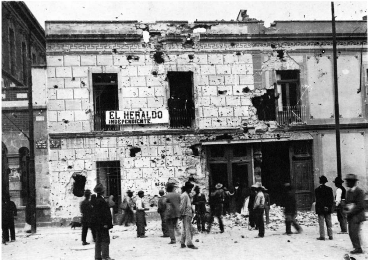
1. Edificio destruido de El Heraldo Independiente
