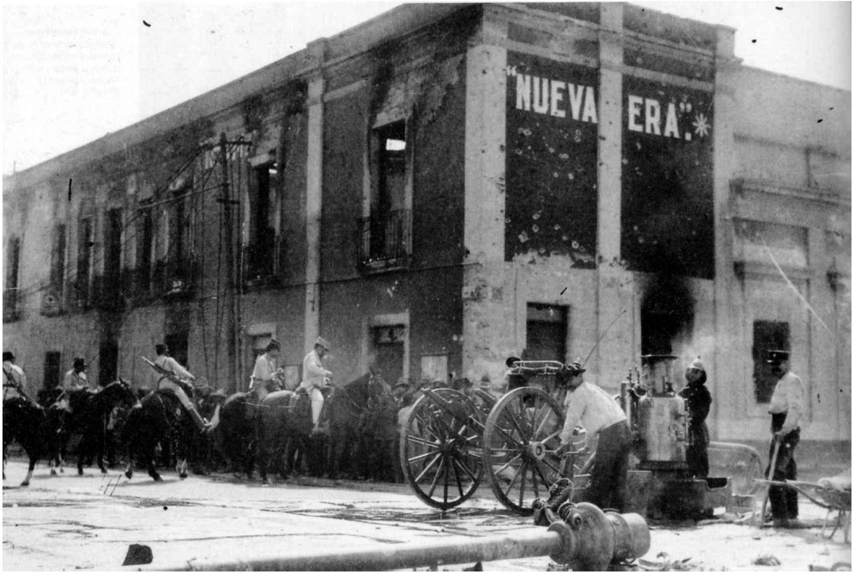
5. Tropas huertisas frente a las oficinas del periódico, después de los destrozos
