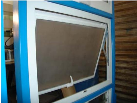
Figura 6 Ventana de movimiento angular tipo proyectable
