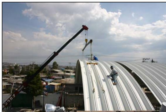
*Fig. IV.22 Montaje de Módulos*
