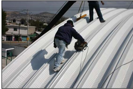
*Fig. IV.23 Engargolado de Módulos*
