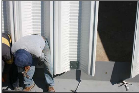
*Fig. IV.20 Fijación de los Módulos con pernos, placas y tuercas al canalón.*
