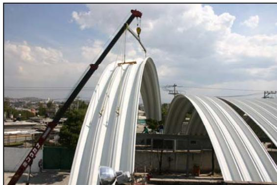
*Fig. IV.19 Elevación de Módulos con grúa*
