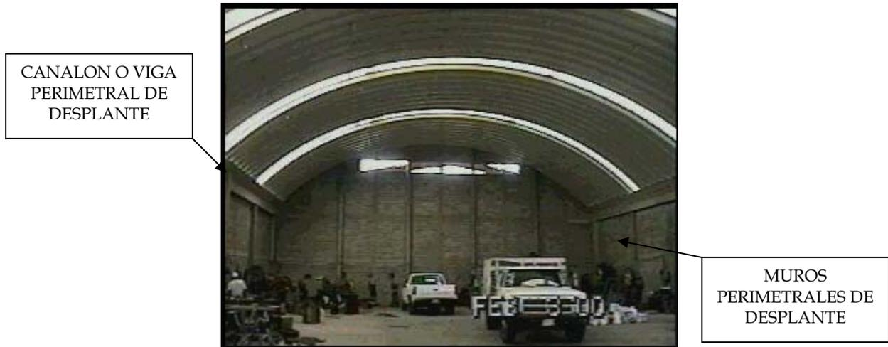
Fig. I.9 Arcotecho tipo membrana
