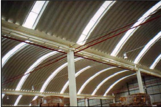
*Fig. I.14 Solución para claros mayores a 35 m en donde se aprecia la estructura de soporte intermedia*
