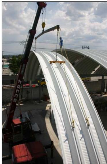
*Fig. IV.21 Montaje de Módulos*
