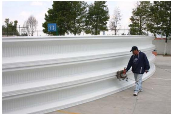
*Fig. IV.18 Engargolado de módulos*
