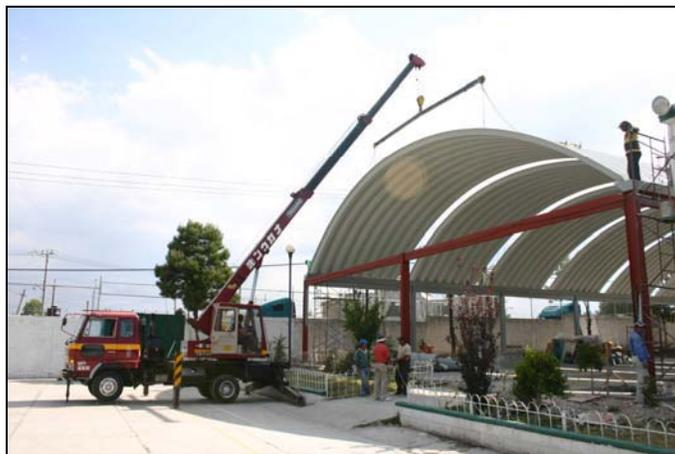
*Fig. IV.24 Preparación para colocar lámina acrílica*
