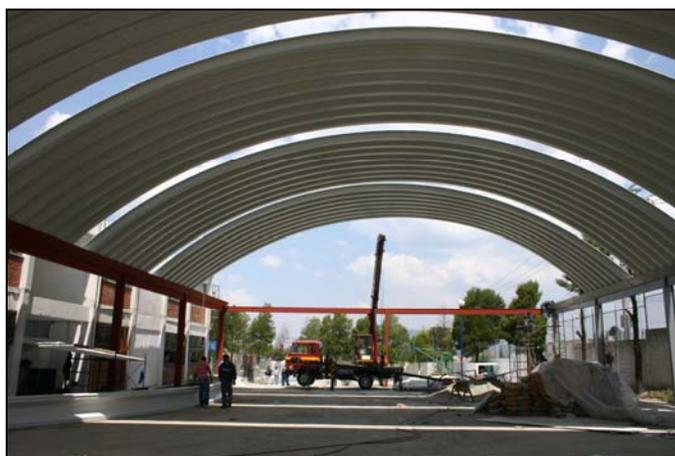
*Fig. IV.25 Preparación para colocar lámina acrílica*
