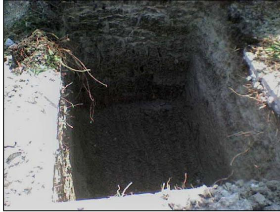
**Fig. IV.1 Excavación para alojar zapata de 2.00 x 1.50 m**
