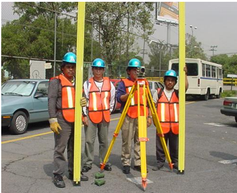
Figura 13. Brigada de nivelación la UDPM, con equipo NA2 marca Wild y 2 miras de nivelación invar con nivel esférico integrado.
