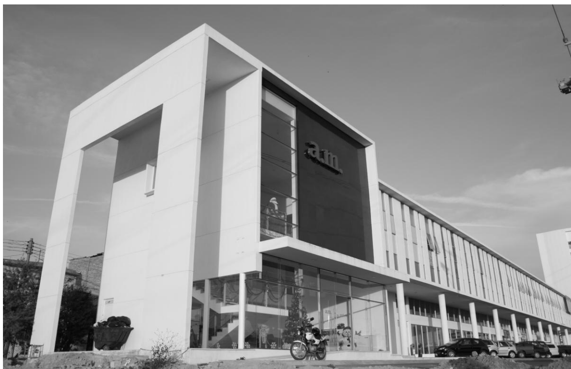
La fachada del nuevo edificio de las instalaciones de a.m. Celaya
