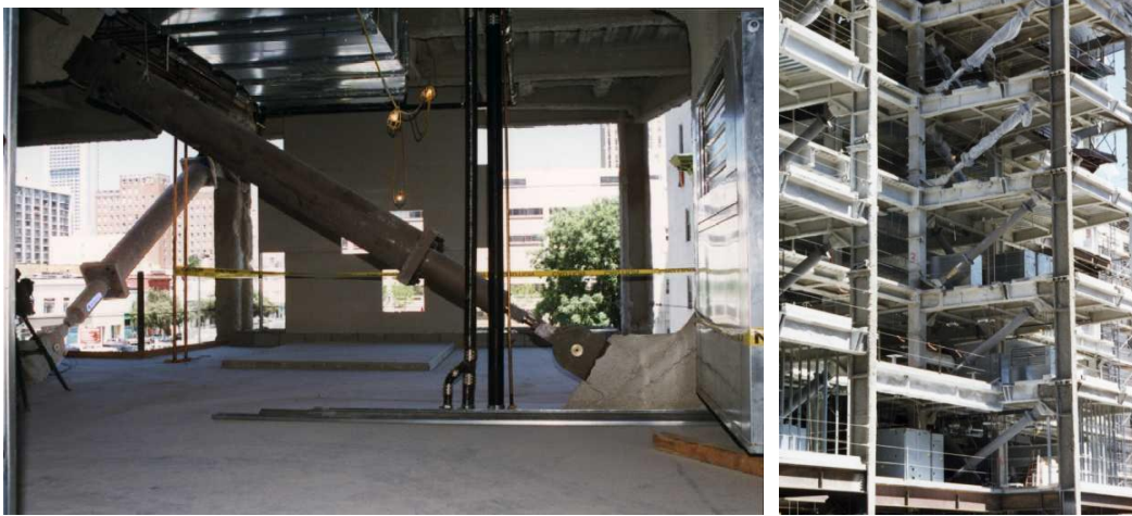
Figura 1.4 Disipadores viscosos
