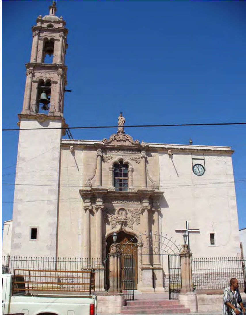
Figura 3.21. Iglesia de Santo Santiago Apóstol, Mapimí
