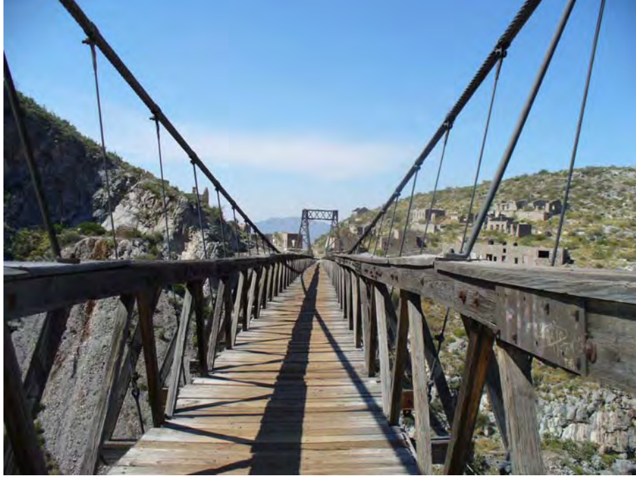
Figura 3.9. Puente de Ojuela. Perspectiva de la entrada oriente.
