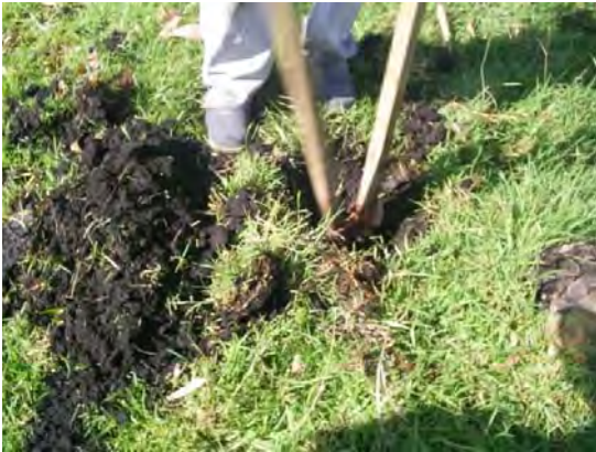
Excavación del hueco
