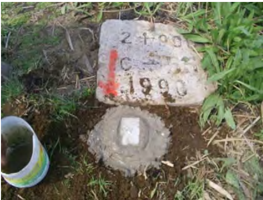
Colado del tubo
