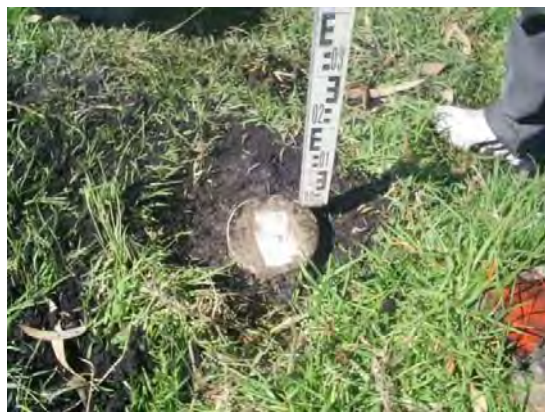
Nivelación del Banco de Nivel
