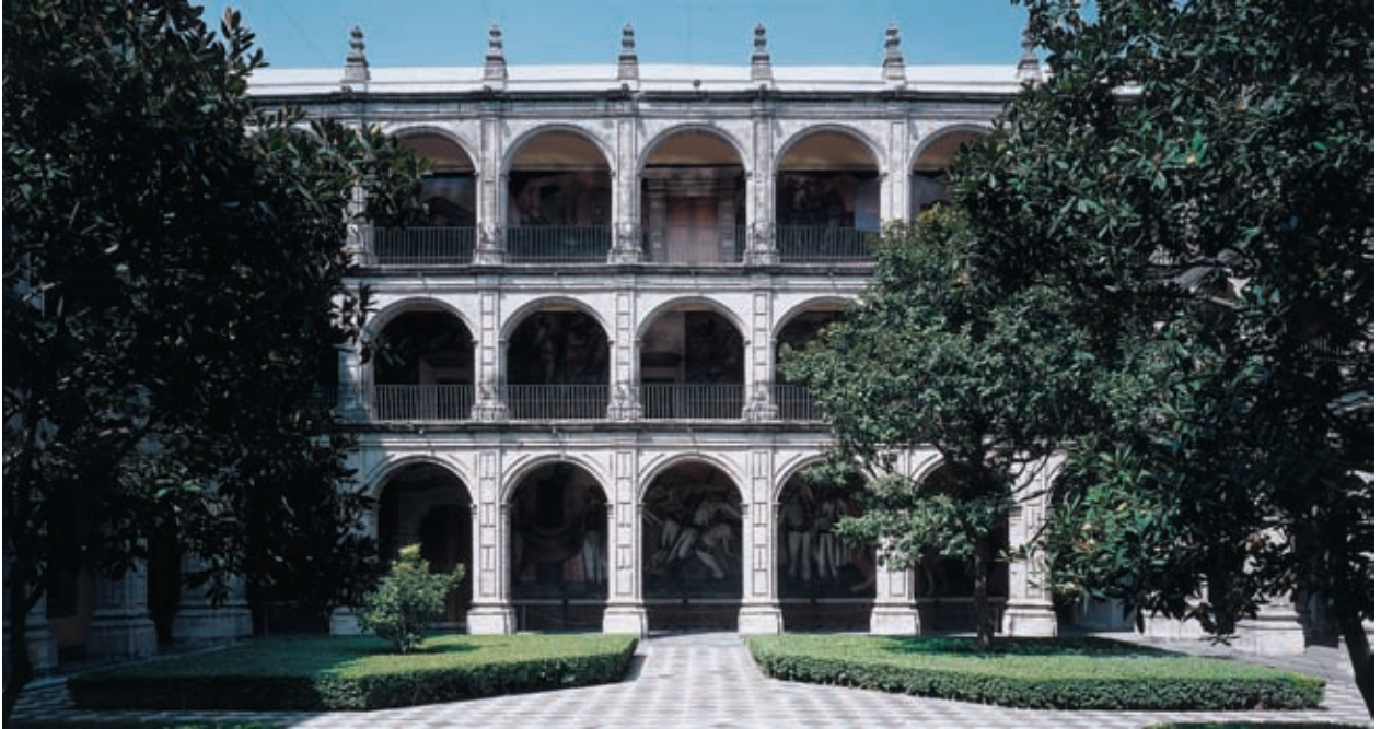
Vista de una de las áreas del Colegio desde el Patio Principal, pueden observarse algunos de los murales que abarcan las paredes de los tres niveles del recinto, mismos que serán descritos más adelante.
