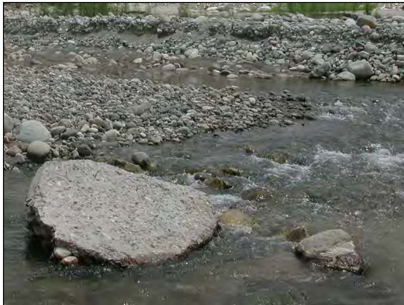
Fotografía 9 Río Coapa, se observa dentro del lecho del cauce parte la losa de un puente
