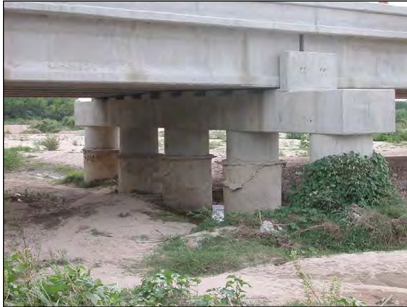
Fotografía 1 Pasaje puente Santa Rosa km 0+300 (río Lagartero)
