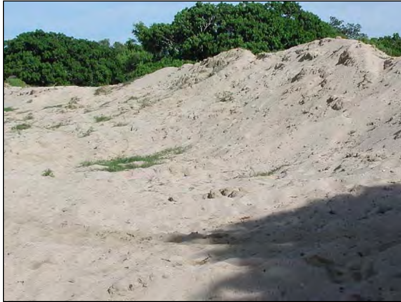
Fotografía 8 Dique recién construido para protección contra inundaciones
