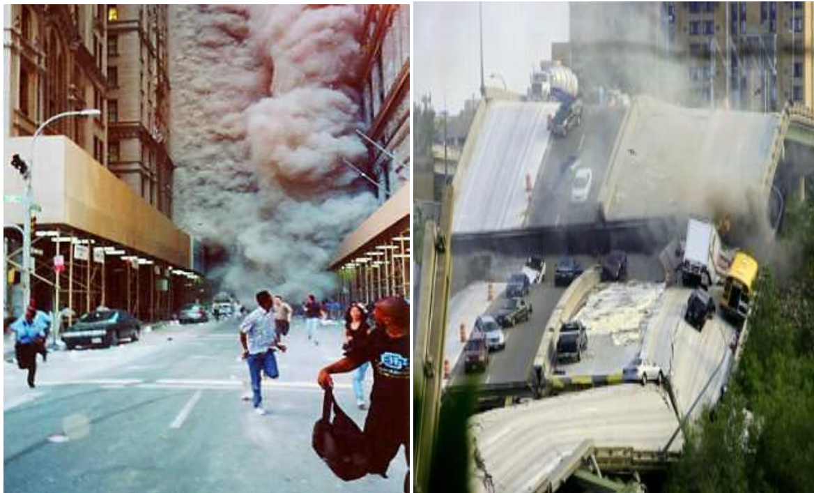
Ilustración 6: Estados Unidos. El deterioro, ataques terroristas, etc destruyen la infraestructura
