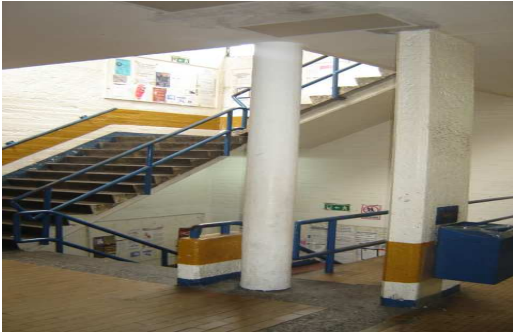
Fig. V.2.5.4. Columna por confinamiento con el sistema MBrace en la Facultad de Derecho (Entrepiso 1), escaleras sur (salida a zona de Islas).
