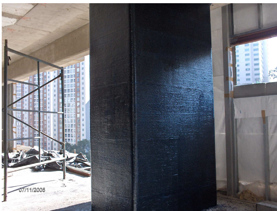
Fig. V.2.5.1 Acabado de una columna por confinamiento.
