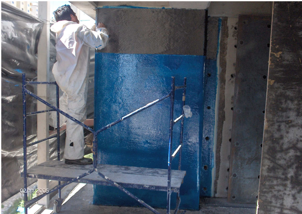
Fig. V.2.4.1 Terminando de colocar el Saturante se procede a colocar la Fibra CF130.
