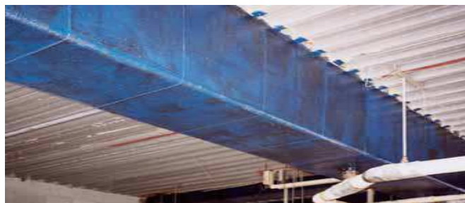
Fig. IV.5.1.2. Refuerzo al esfuerzo cortante de una viga de concreto reforzado.
