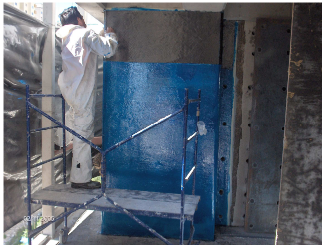
Fig. IV.5.4.Colocación de la fibra
