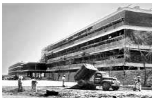
Fig. V.1. Construcción del edificio que ocuparía la Facultad de Derecho en Ciudad Universitaria
