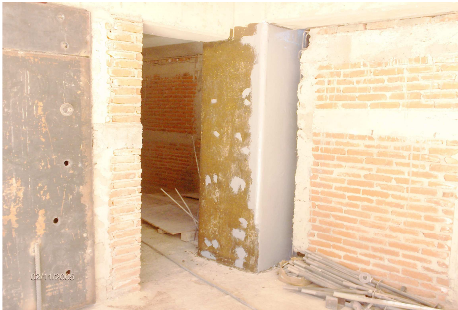
Fig. V.2.3.1. Aplicación de Putty (resanador) sobre Primer en columna.
