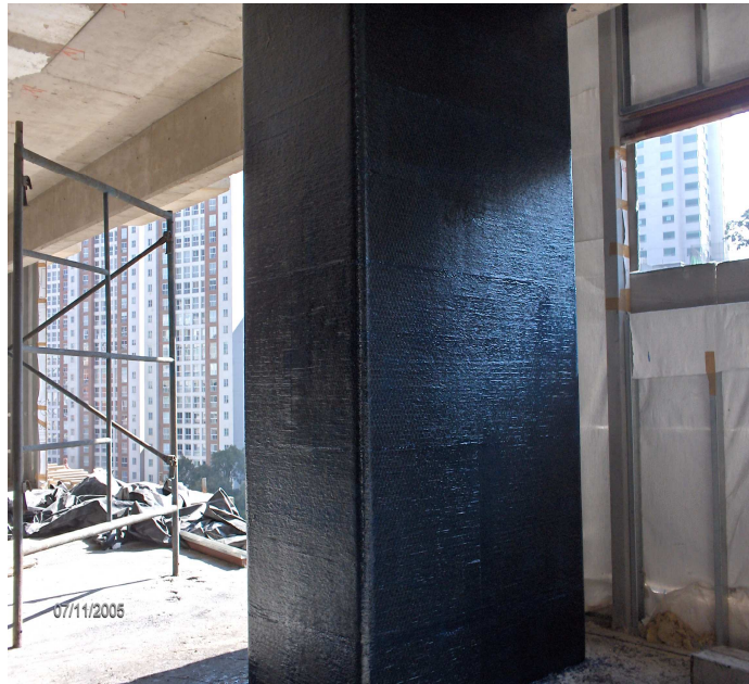
Fig. IV.5.5. Segunda capa de saturación sobre la fibra, para que este encapsulada.
