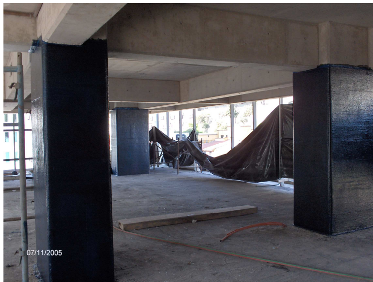
Fig. IV.5.2.3. Confinamiento de columna con fibras de carbono
