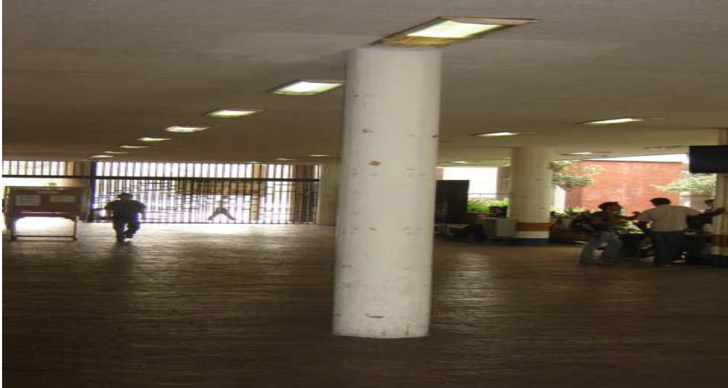
Fig. V.2.5.2 Acabado de una columna por confinamiento con el sistema MBrace en la Facultad de Derecho (Entrepiso Planta Baja), localizada frente a ventanillas de Servicios Escolares.
