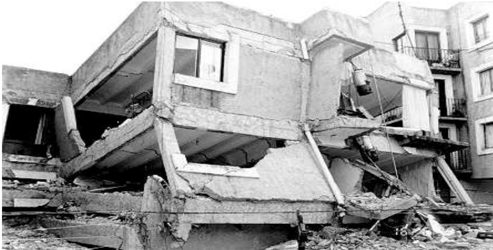
Fig.III.9.4. Daños en edificación donde se usó sistemas de piso de vigueta y bovedilla. Se aprecia el inadecuado diseño de los elementos estructurales de los marcos, y el adecuado comportamiento rígido del sistema de piso de vigueta y bovedilla (Sismo de Tehuacan, Puebla, 1999)
