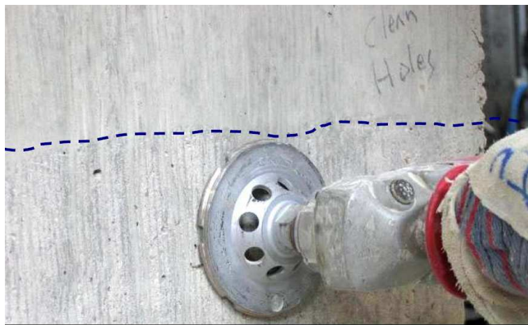
Fig.V.2.1. Limpieza del concreto con esmeril con disco de tungsteno.
