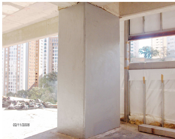
Fig.IV.5.3. Aplicación del putty en columnas.
