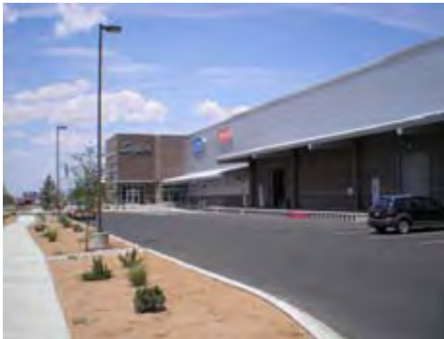
Vistas Exteriores del Edificio
