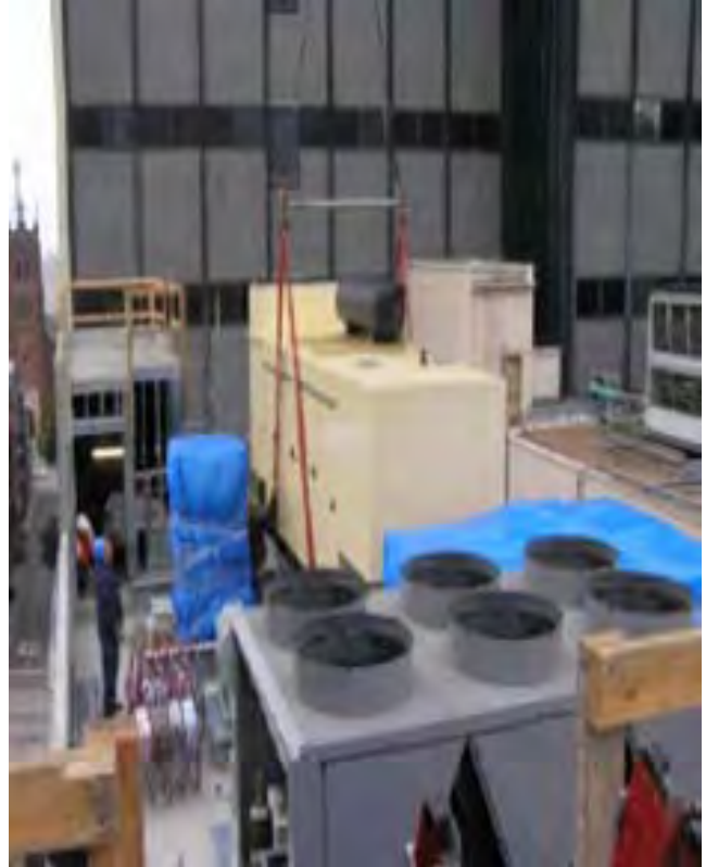
Sistemas de Ventilación, Calefacción y Aire Acondicionado
