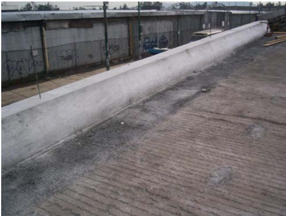
Parapeto de concreto
