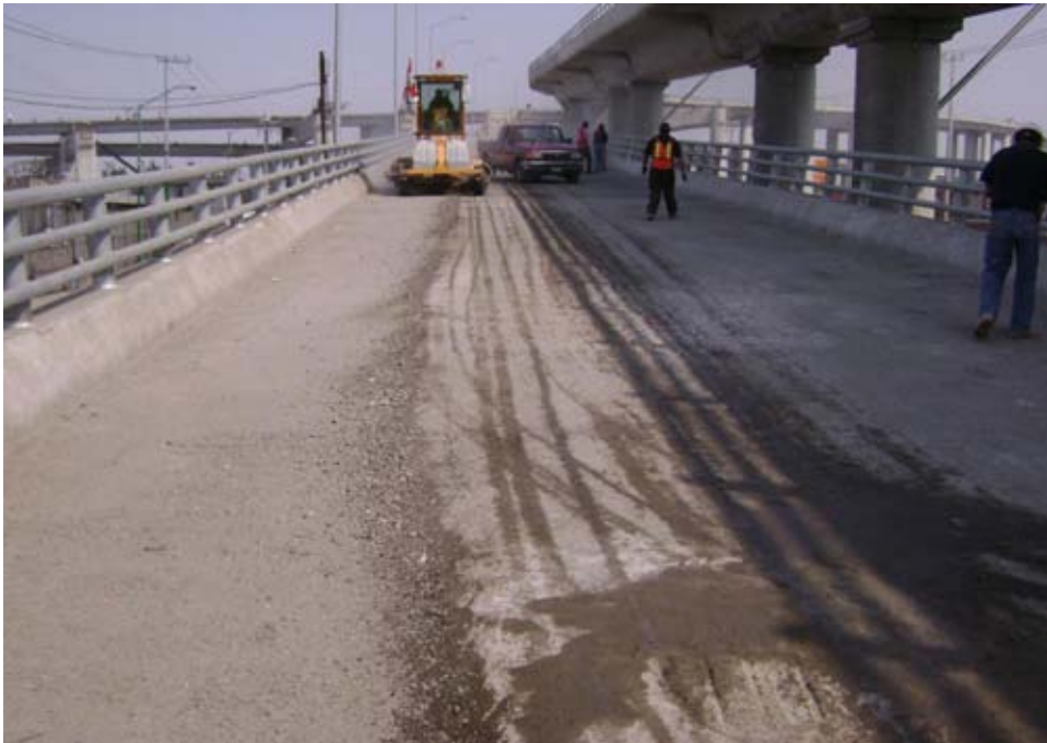
Limpieza del firme de compresión
