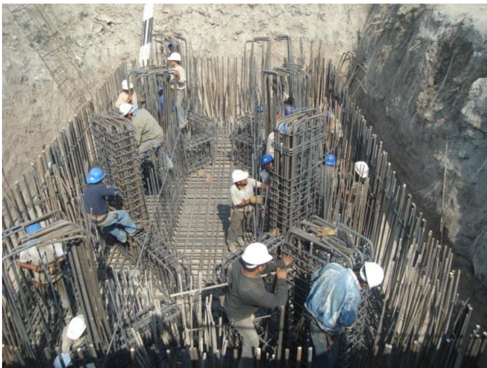
Armado de contrafuertes
