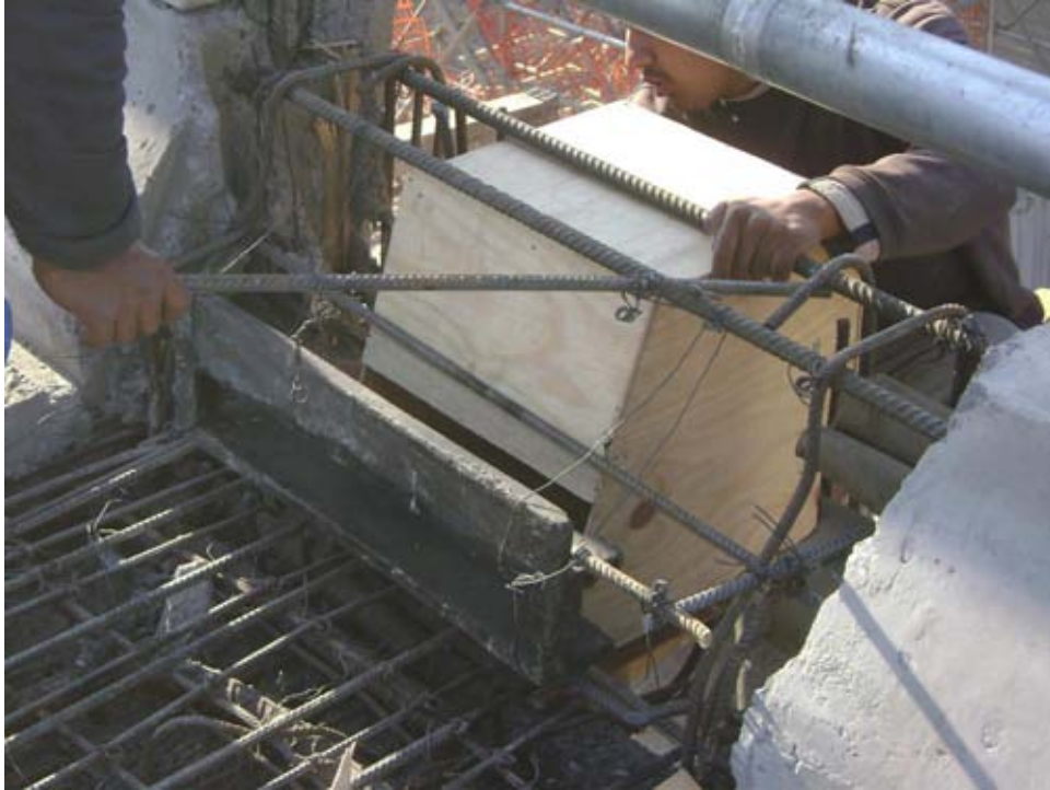
Colocación de rejilla
