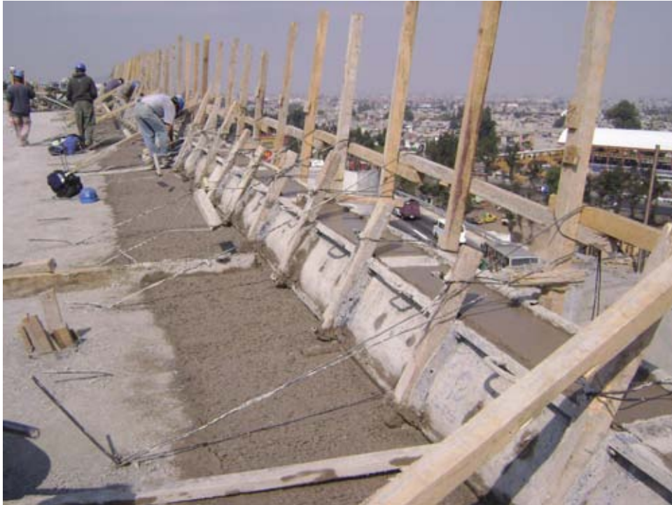
Colado de parapeto
