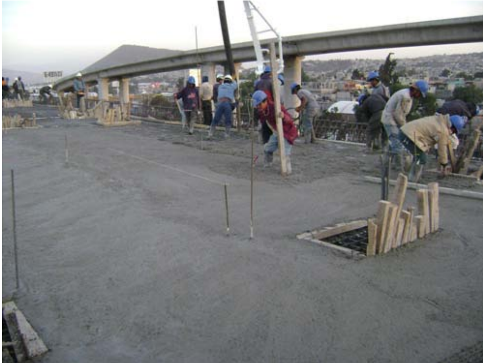
Colado de firme
