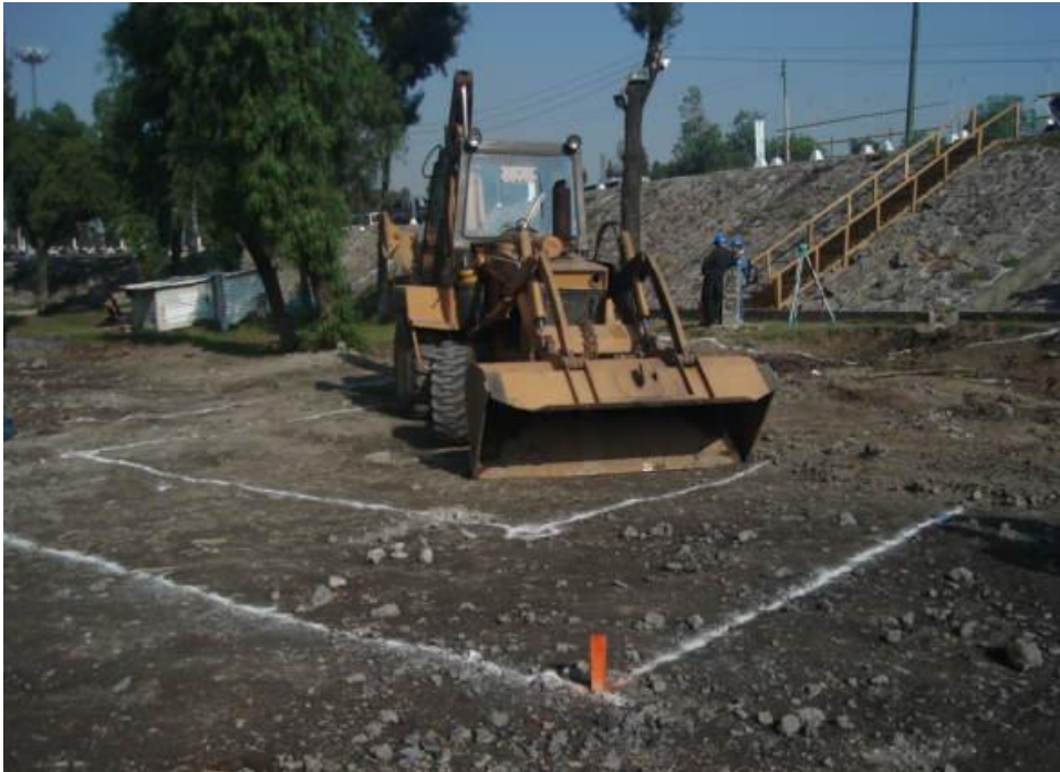
Trazo de perimetral de zapata y sobreexcavación
