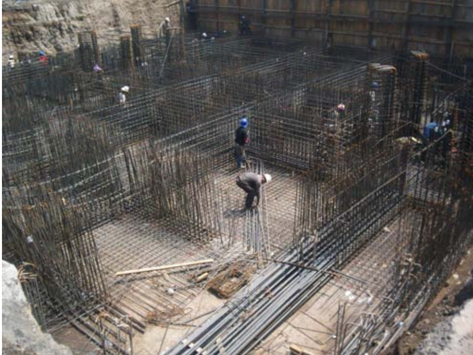
Armado de traves y contratraves
