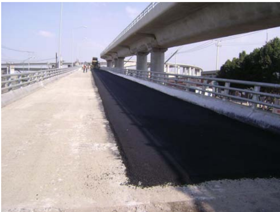
Colocación de carpeta reniveladora
