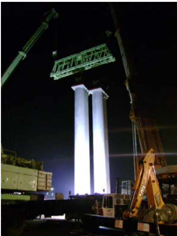
Montaje en eje “A”
