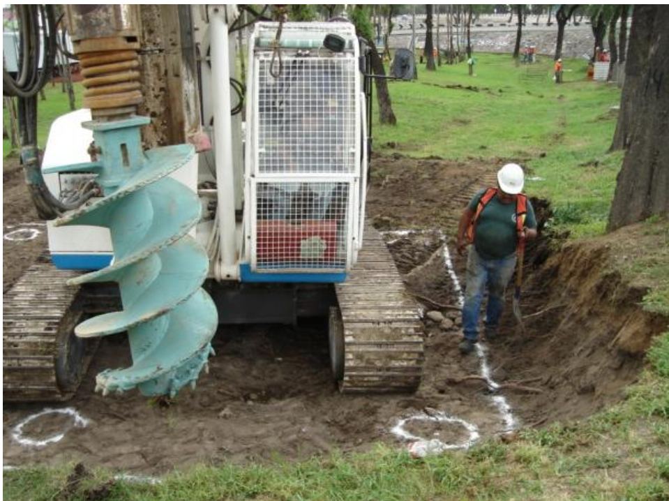
Preparación del equipo de perforación
