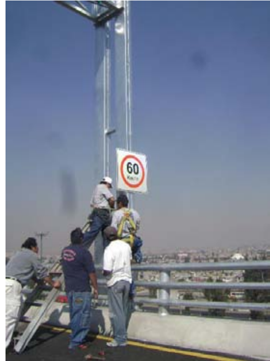
Colocación de señalamientos
