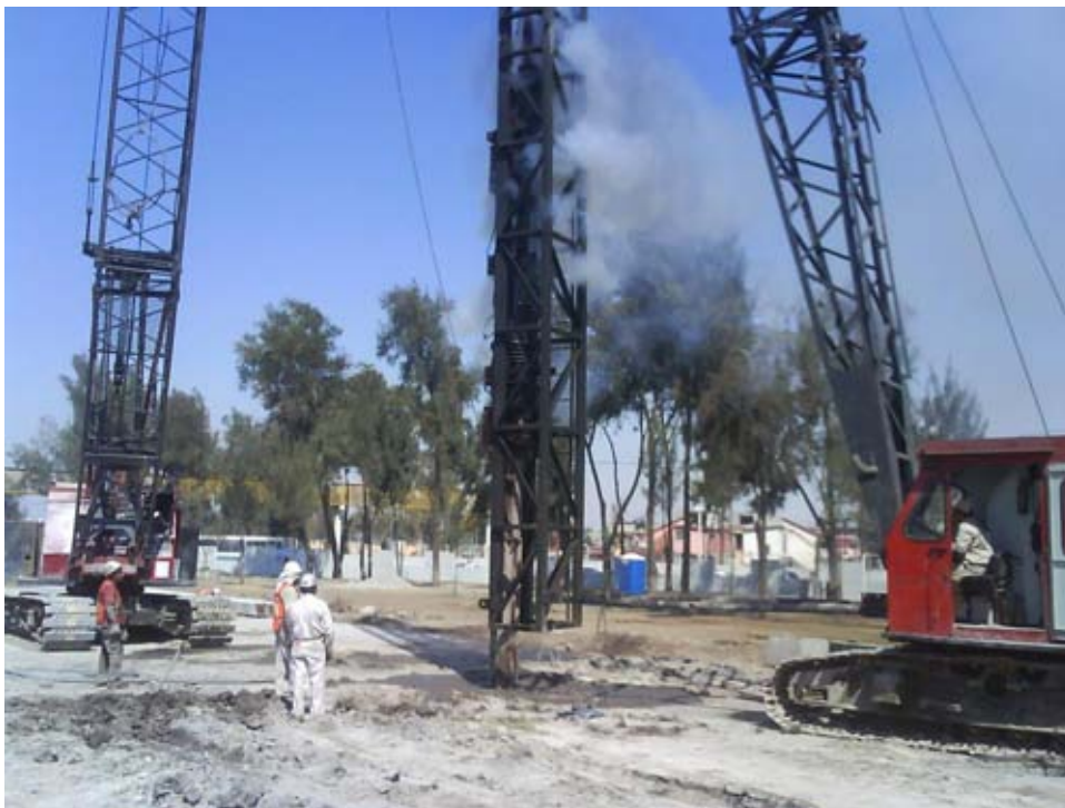
Hincado de pilotes
