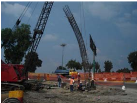
Colocación de acero de refuerzo
