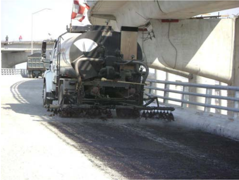
Colocación del riego de liga
