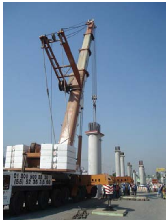
Montaje en eje “C”
