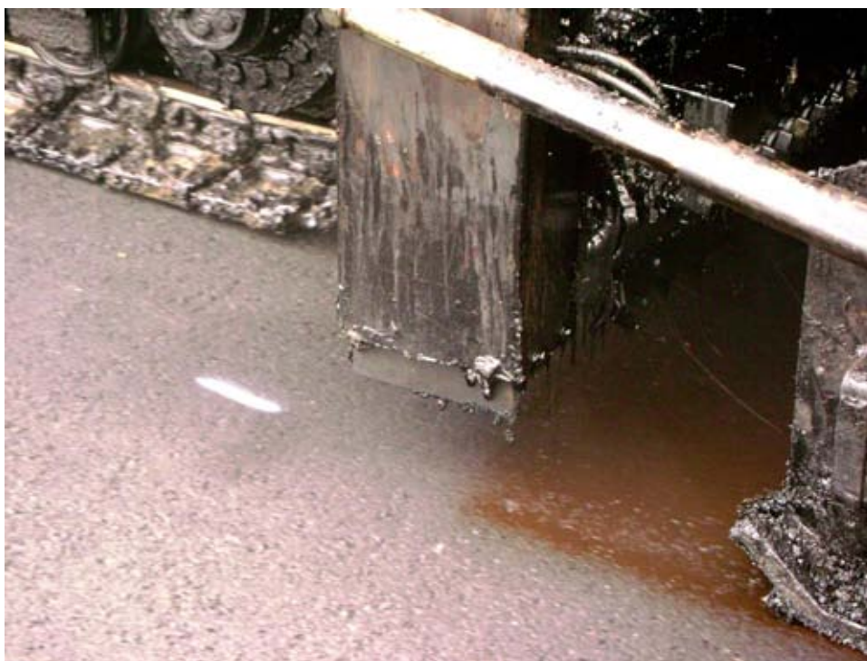
Riego de liga simultaneo a la colocación de la carpeta
