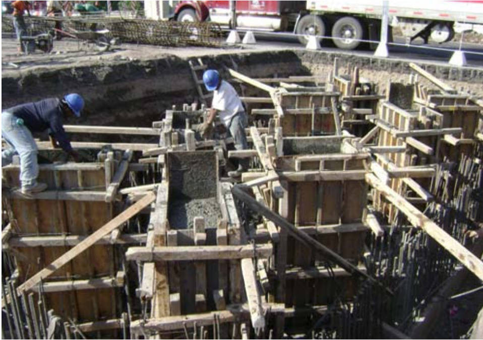
Colado de contrafuertes
