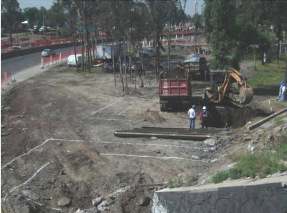
Inicio de excavación
