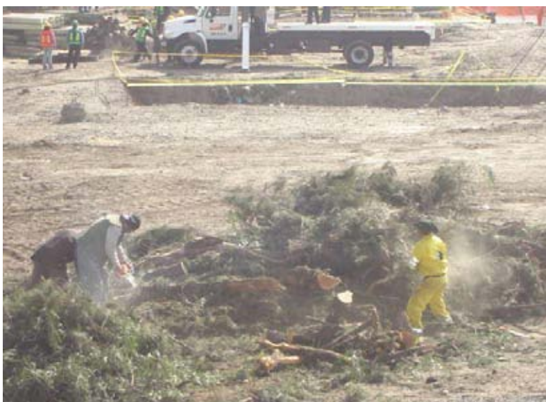
Derribo de árboles
