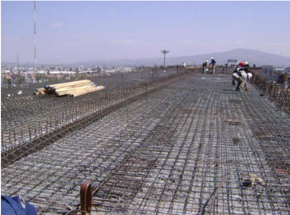
Acero de refuerzo para firme de compresión
