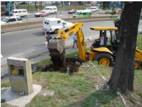
Despalme de terreno de acuerdo al trazo de la zapata
