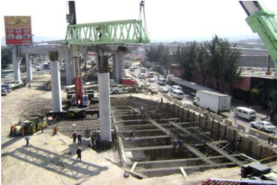
Apoyo sobre losa tapa para montaje
