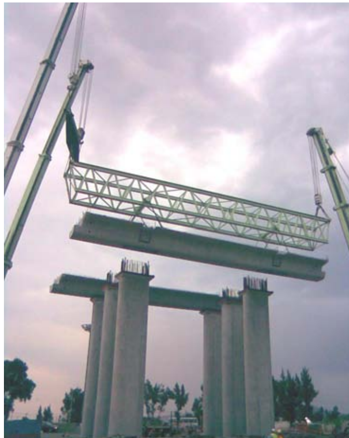
Montaje de trabe tipo TA
