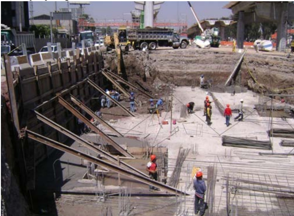
Colocación de tablestacado en cara de colindancia directa con vialidad
