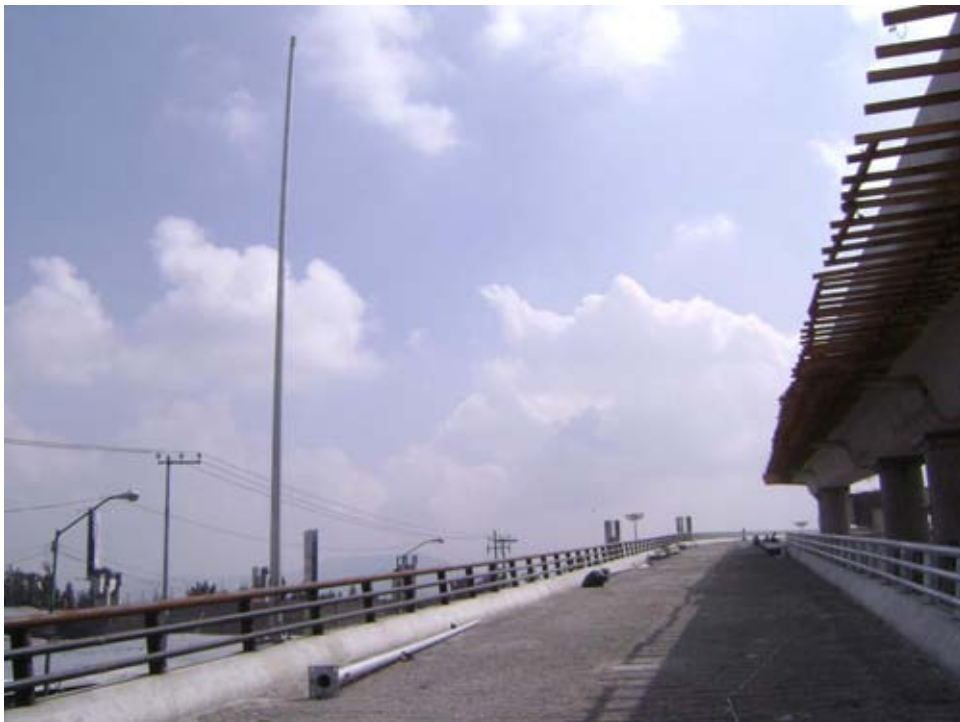
Colocación de postes
