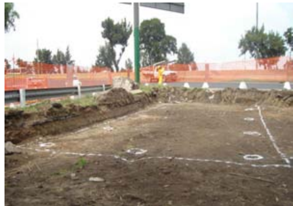
Trazo de zapata y ubicación de pilotes
