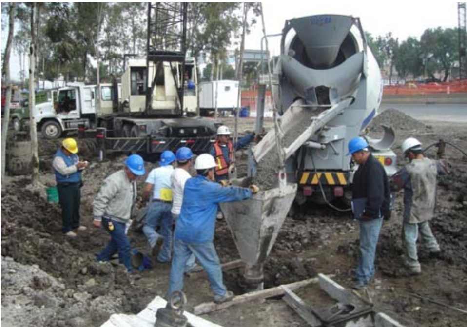
Colado de Pila
