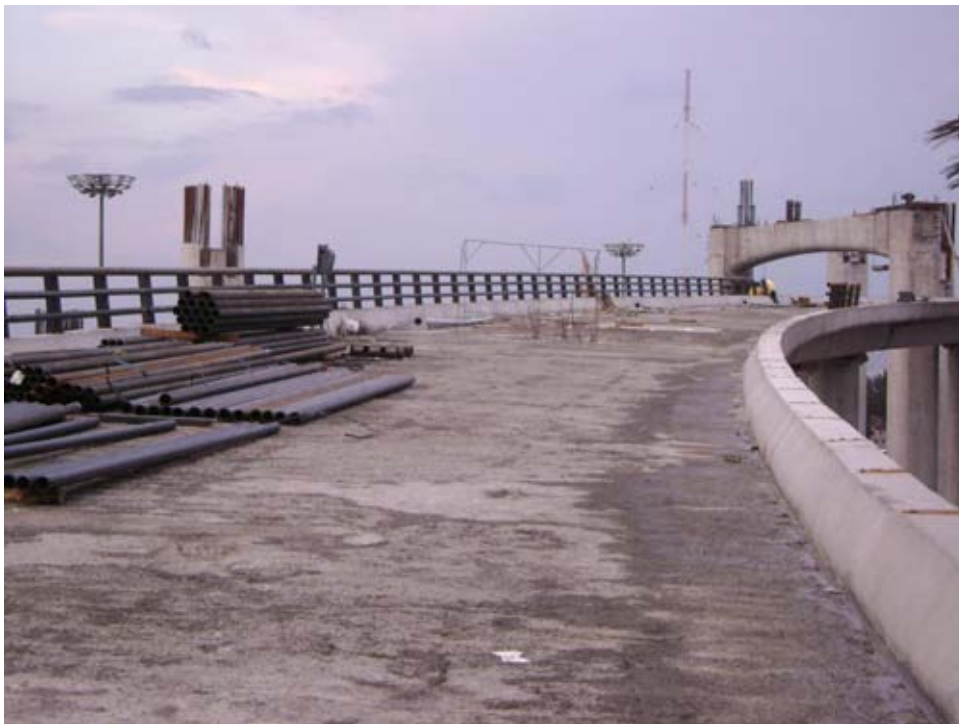
Colocación de parapeto
