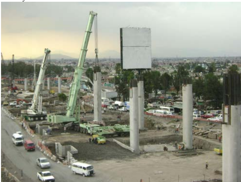
Montaje en eje "A"
