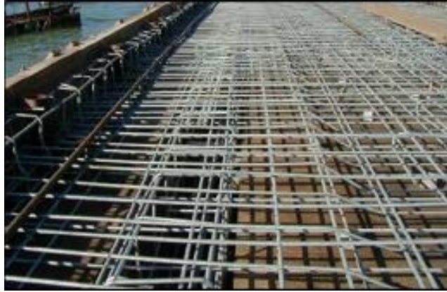
Fig. 5.2 Acero de refuerzo colocado en obra marítima
