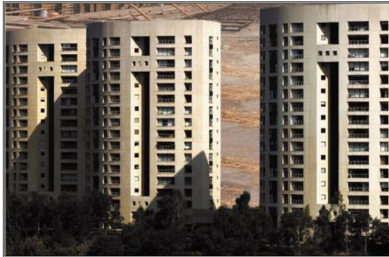
Fig. 5.1 Construcciones representativas de la utilización de concreto armado
