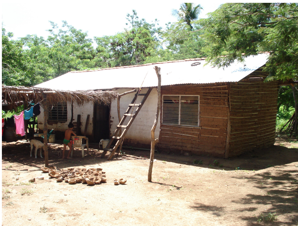
Imagen IV.19 Vivienda en el municipio de Coyuca de Benítez. Realizada con una combinación de materiales de la región y materiales industrializados (la cubierta de lámina y las ventanas y puertas metálicas). Se pueden apreciar las huellas de sucesivas inundaciones en el predio.
