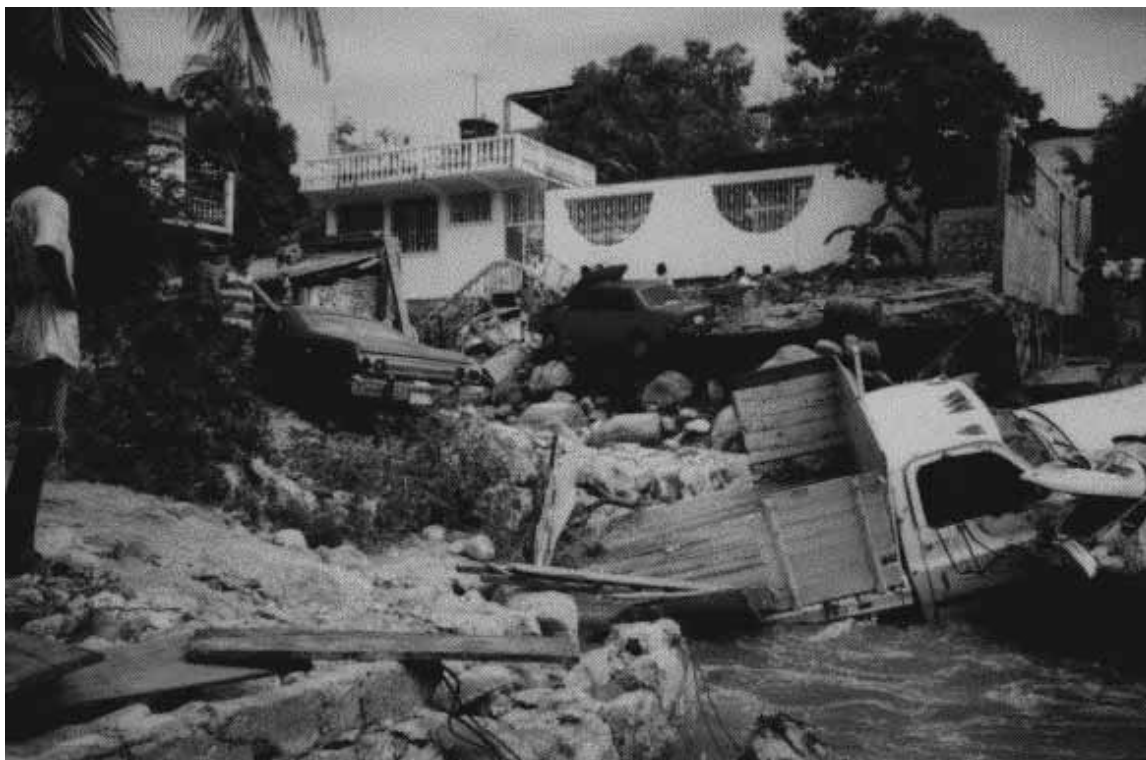
Imagen IV.6 Arrastre de vehículos en el cauce del río El Camarón en Acapulco. Foto: R. Durán. CENAPRED
