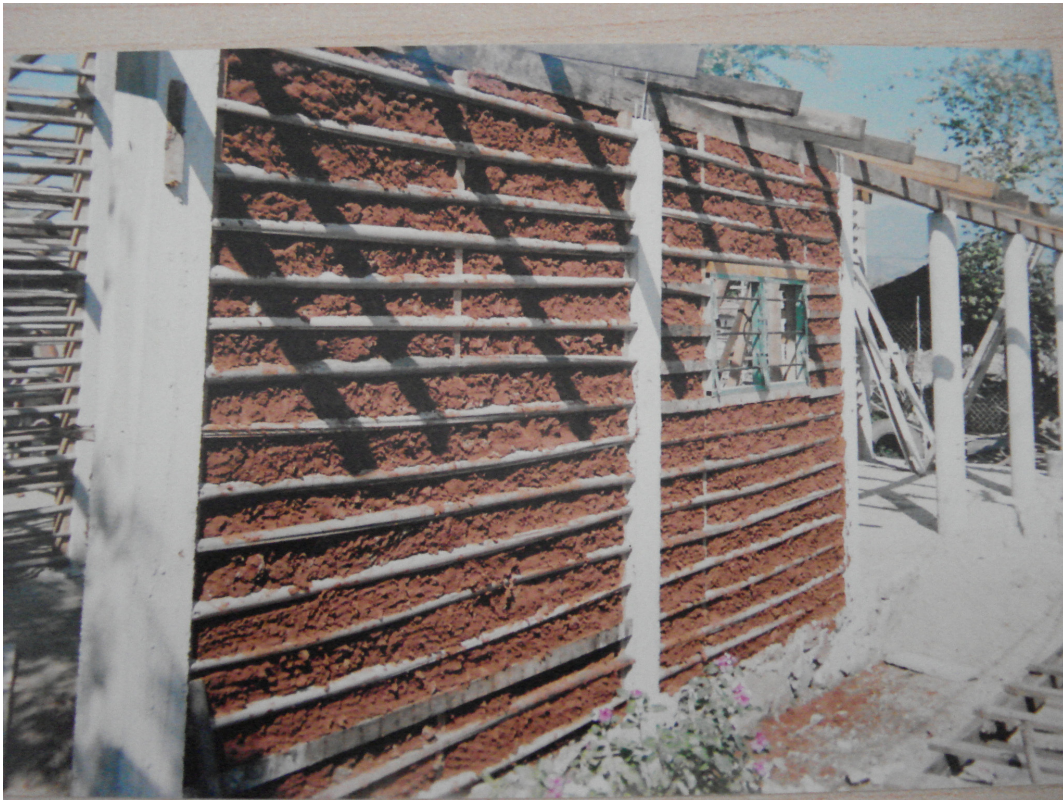
Imagen IV.11 Vivienda de bajareque reforzado con castillos de concreto armado en el municipio de Tecpan de Galeana promovida por la Fundación Gilberto. (Fuente: INVISUR)
