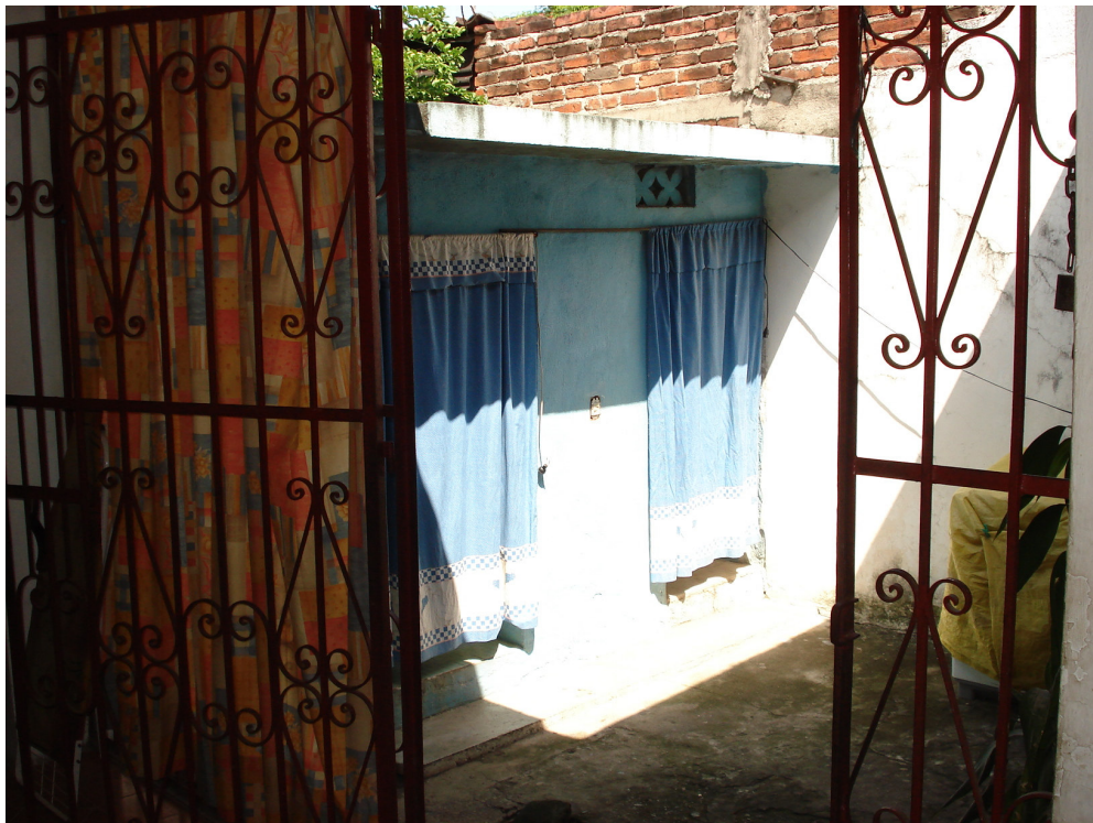
Imagen V.8 Cuarto de baño anexo al cuerpo principal de la vivienda en la ciudad de Tecpan de Galeana.
