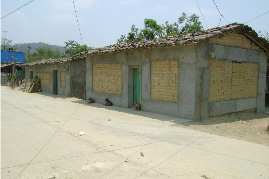
Imagen IV.10 Otra perspectiva del reforzamiento de las viviendas para hacerlas mas resistentes a los sismos.
