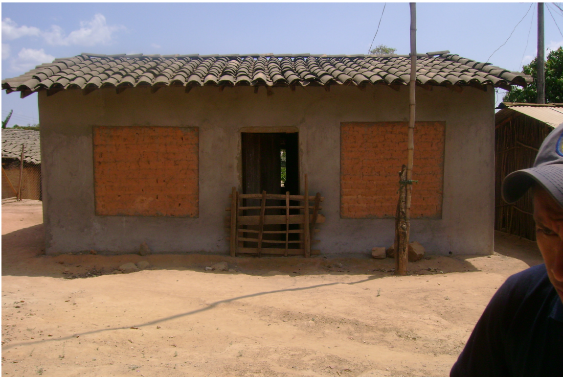
Imagen IV.9 Reforzamiento de viviendas de adobe a base de malla estructural y mortero en la comunidad de Tlacoachistlahuaca con recursos del FONDEN en la región de la montaña de Guerrero. Este mismo sistema se está aplicando en la Costa Grande con recursos del mismo programa.
