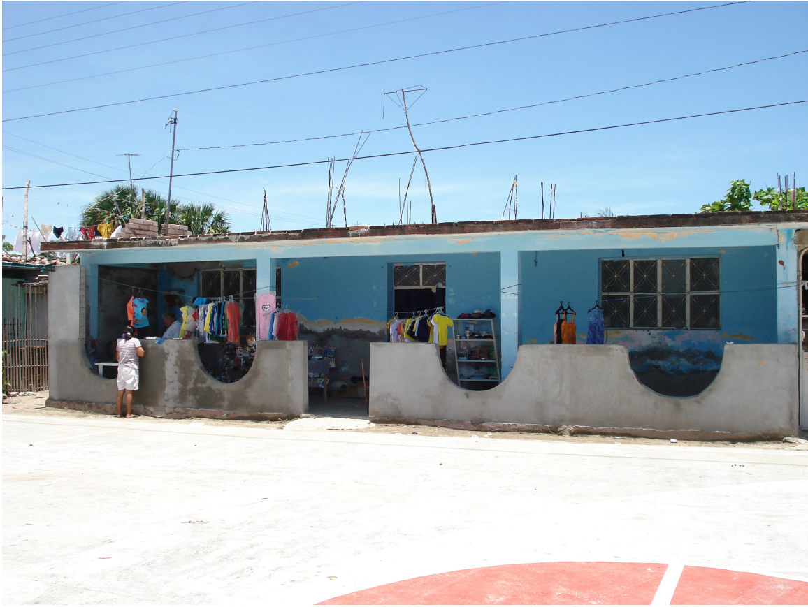
Imagen IV.8 En los lugares donde es común el desbordamiento de ríos y lagunas la gente ha optado por modificar el diseño de sus viviendas cambiando materiales de construcción que resistan la erosión y por levantar un murete en el pórtico para contener el flujo del agua e impedir que penetre en la vivienda. Imagen de El Embarcadero en el municipio de Coyuca de Benítez.
