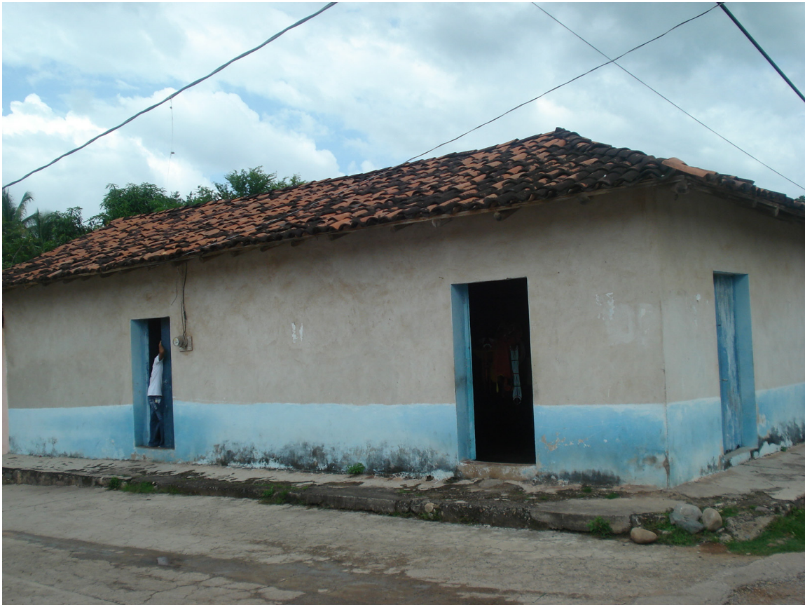
Imagen V.13 Casa sin pórtico en La Unión
