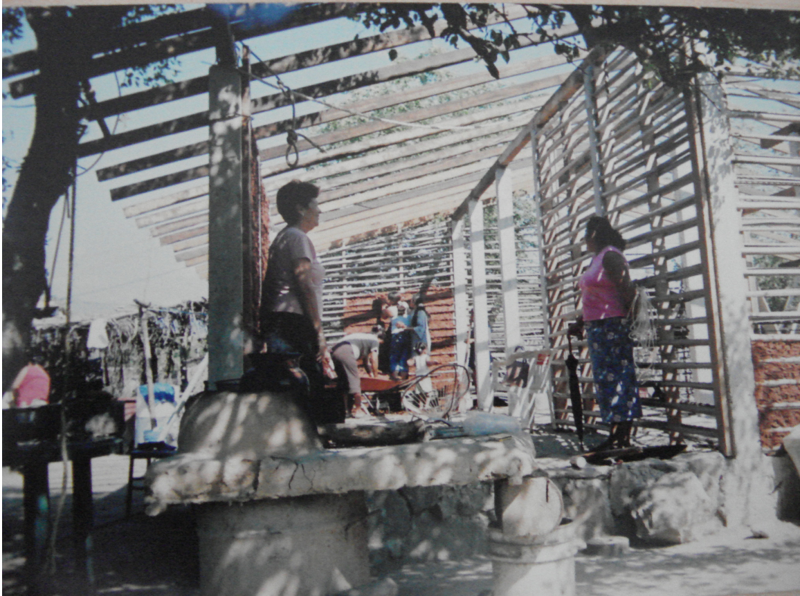
Imagen IV.12 Otra perspectiva con la población trabajando en la construcción de sus viviendas de bajareque reforzado en el municipio de Tecpan de Galeana. (Fuente: INVISUR)
