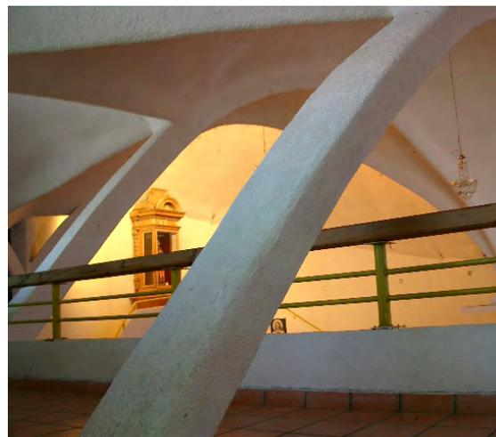
La forma y el espacio en esta edificación, son generados fundamentalmente por el sistema estructural y constructivo elegido: los cascarones de doble curvatura construidos de concreto armado sin cimbra, una tecnología “Apropiada y Apropiable” como
