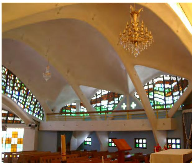
este caso particular el sistema empleado tiene la característica de que las cubiertas se desplazan y se convierten en nervaduras de apoyo dejando los costados de la estructura abiertos, debiendo adicionarse elementos constructivos para lograr el control ambiental.
