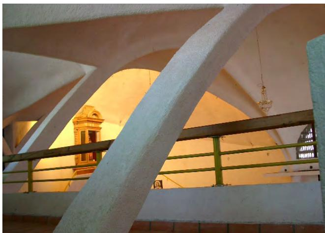
sentido estático característica de los edificios anteriores, e introduce las superficies de doble curvatura y con ellas el dinamismo provocado por la intersección de dos curvas, la parábola y la hipérbola.
