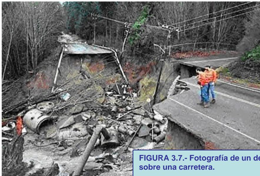
**FIGURA 3.7.- Fotografía de un derrumbe sobre una carretera.**
