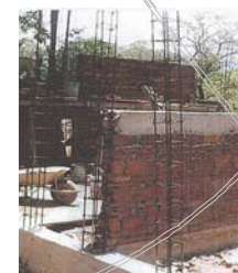
columnas, castillos, cadenas y muro de tabique.
