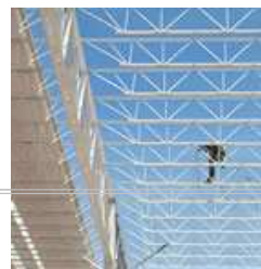
Armaduras alma abierta
