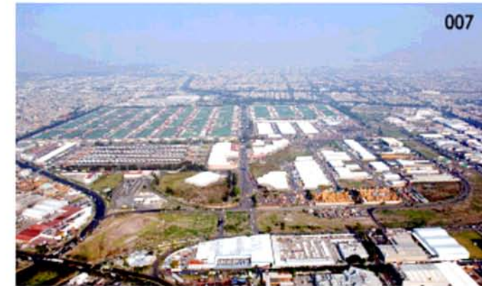
Imagen 005. Muestra la Central de Abasto de la Ciudad de México, donde se aprecian vialidades, accesos y salidas así como la estructura comercial y de servicios que operan en ella.
