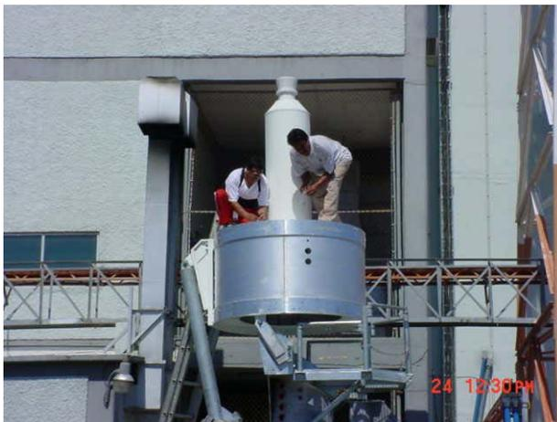
**Montaje del alimentador de la antena parabólica**
