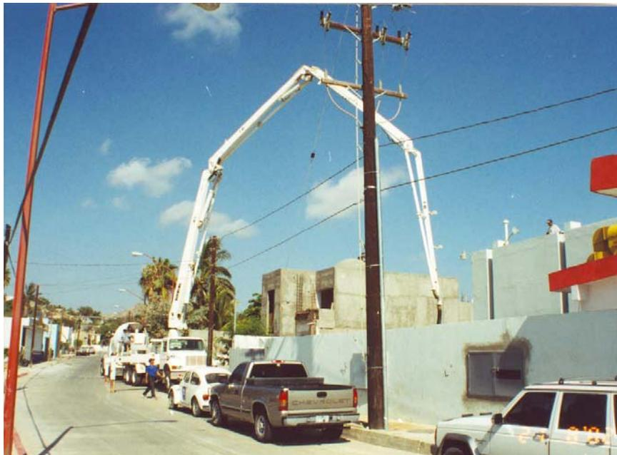
**Colado de concreto con uso de máquina de bombeo debido al poco espacio para entrada de camiones**
