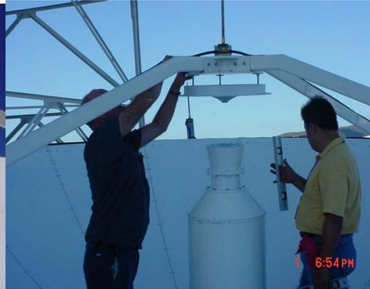
**Instalación de guía de onda y ajuste del subreflector**
