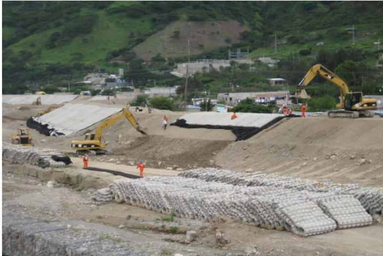
Foto 24. Construcción de bordos de protección en el río Xelajú. Fuente: Eduardo Morales. Julio de 2007
