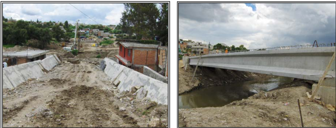
Figura 2.- A la izquierda una foto de la calle que desemboca al paso vehicular que cruza el Río Aguililla. A la derecha la subestructura del paso vehicular sobre el Río Alseseca.
