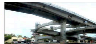
2do Piso del Periférico
