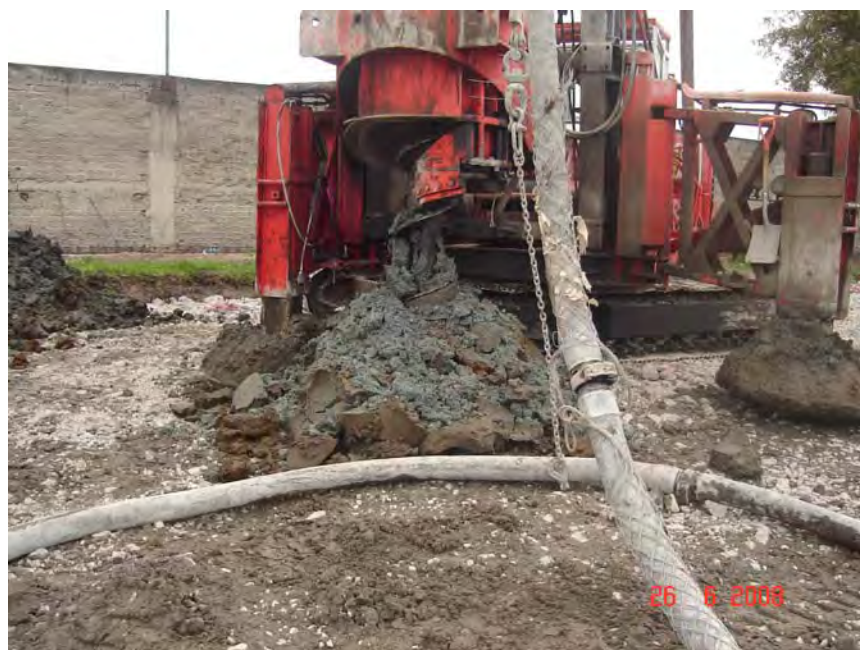
Fig. 8.18 Inyección de concreto, inicio de inyección
