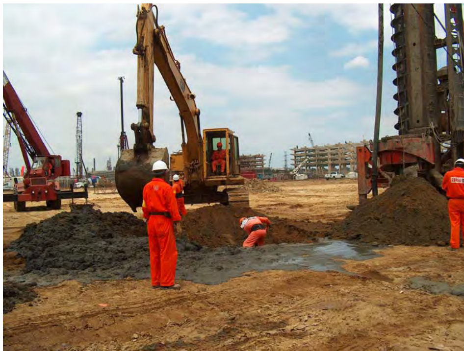
Fig. 8.27 Colocación del brocal, limpieza alrededor de la pila
