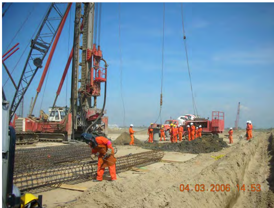
Fig. 8.35 Introducción del acero, asentamiento del acero a la profundidad requerida
