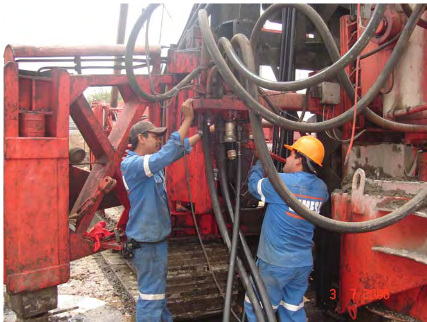
Fig. 8.5 Trabajos preliminares, instalación de sensores y mangueras
