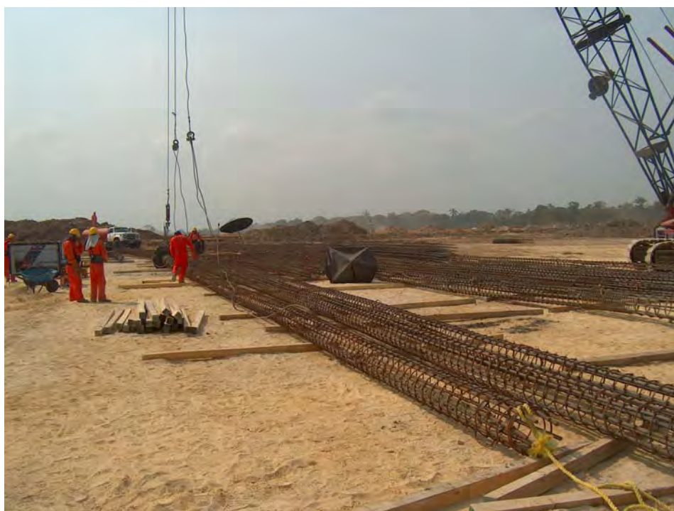
Fig. 8.26 Colocación del vibrador, preparación de los puntos de izaje en el acero
