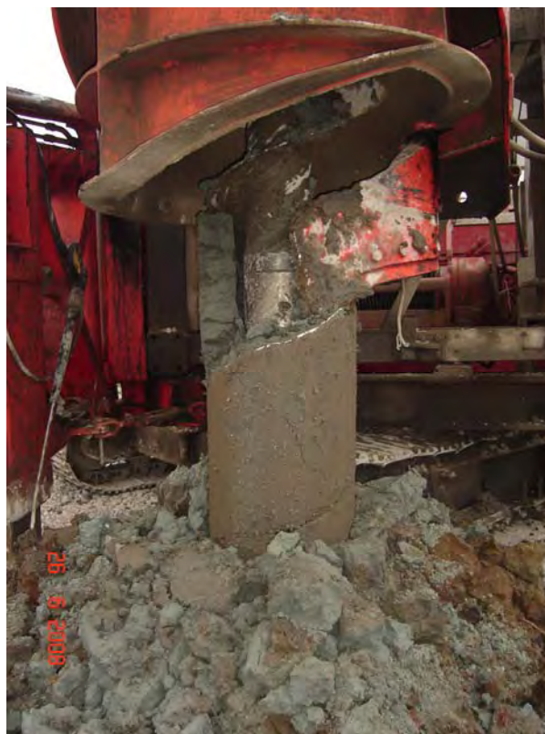
Fig. 8.19 Inyección de concreto, izaje y limpieza de helicoidal
