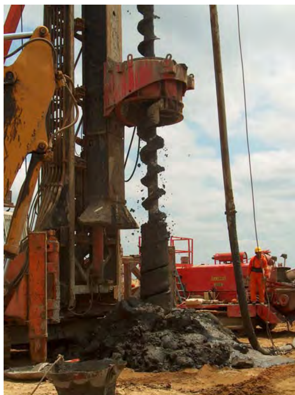
Fig. 8.20 Inyección de concreto, izaje y limpieza de helicoidal
