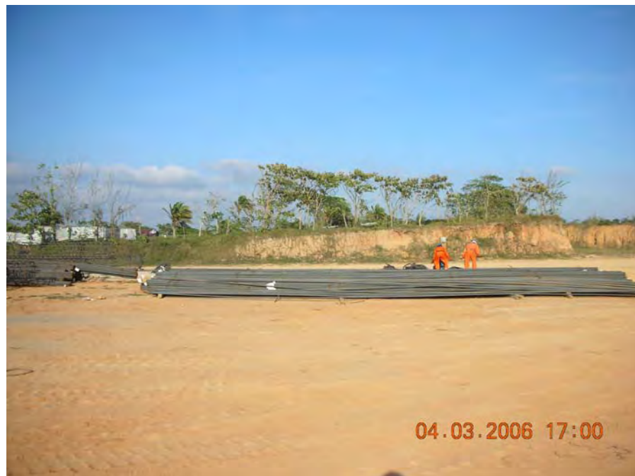
Fig. 8.9 Habilitado del acero de refuerzo, almacenaje
