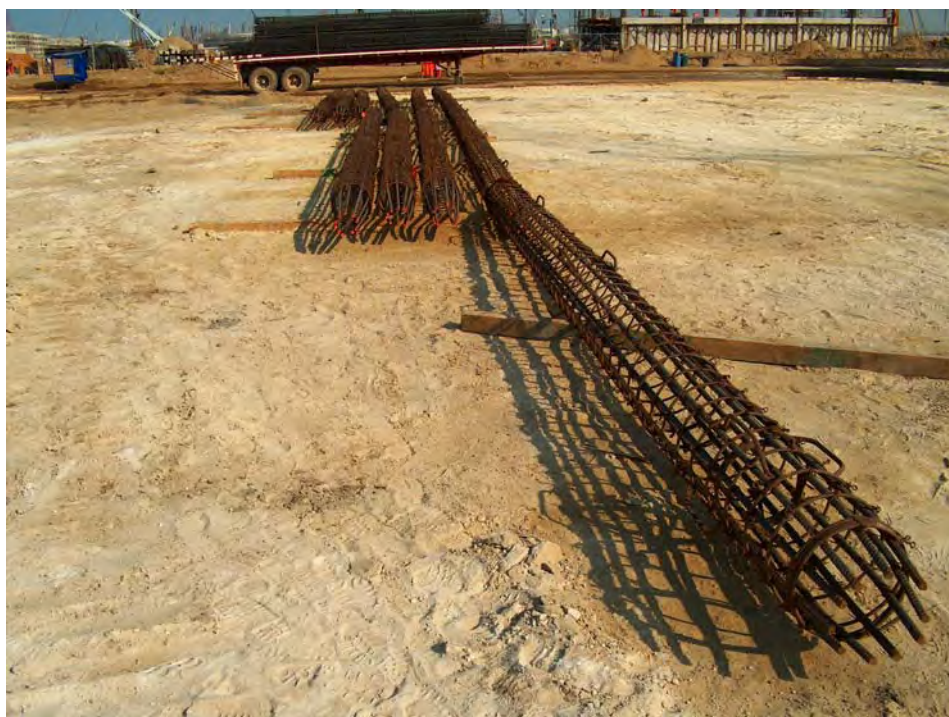
Fig. 8.14 Habilitado del acero de refuerzo, producto terminado
