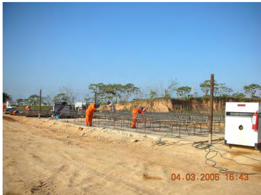
Fig. 8.11 Habilitado del acero de refuerzo, uso de soldadura
