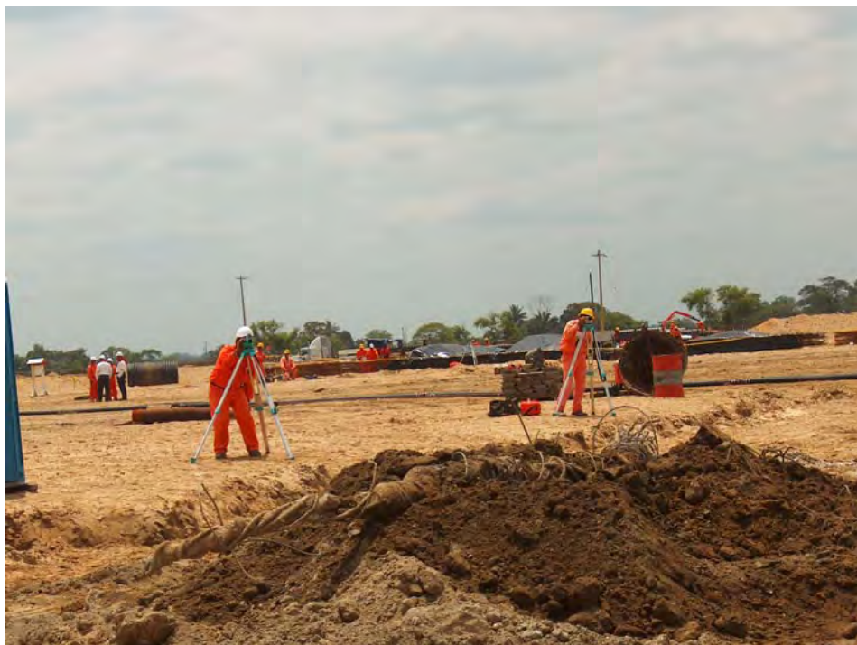
Fig. 8.37 Inspección, uso de equipo topográfico para la localización de pila terminada
