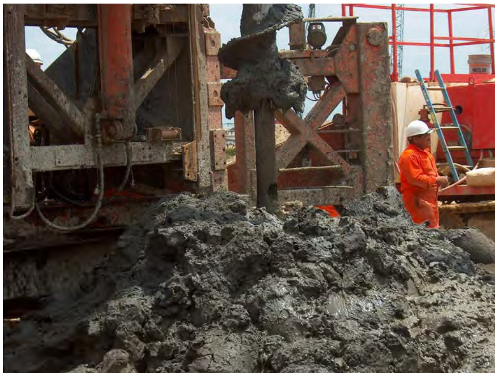
Fig. 8.21 Inyección de concreto, terminación de colado
