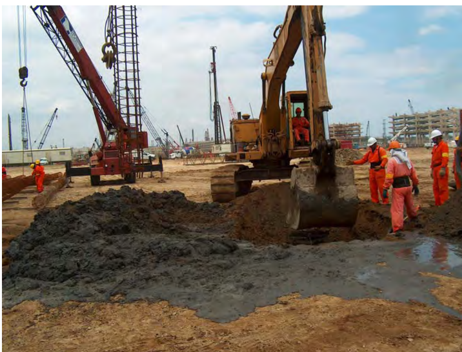
Fig. 8.29 Colocación del brocal, localización de la pila
