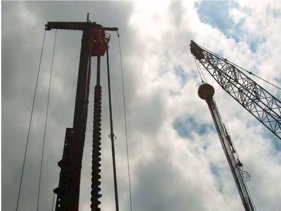
Fig. 8.31 Izado y alineamiento del acero, izado con grúa
