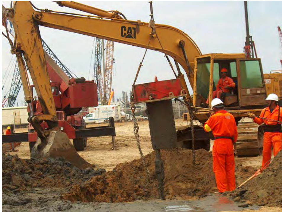
Fig. 8.39 Limpieza, retiro del vibrador
