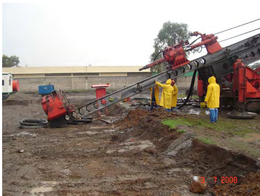
Fig. 8.3 Trabajos preliminares, montaje del bote limpiador
