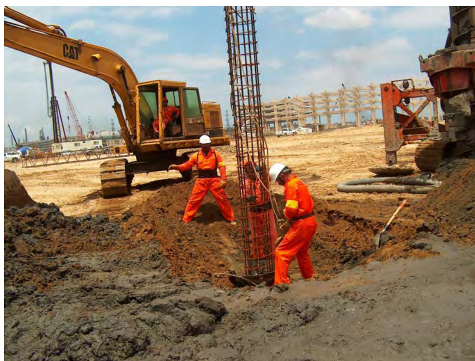
Fig. 8.34 Introducción del acero, retiro de cables antes de introducir el acero
