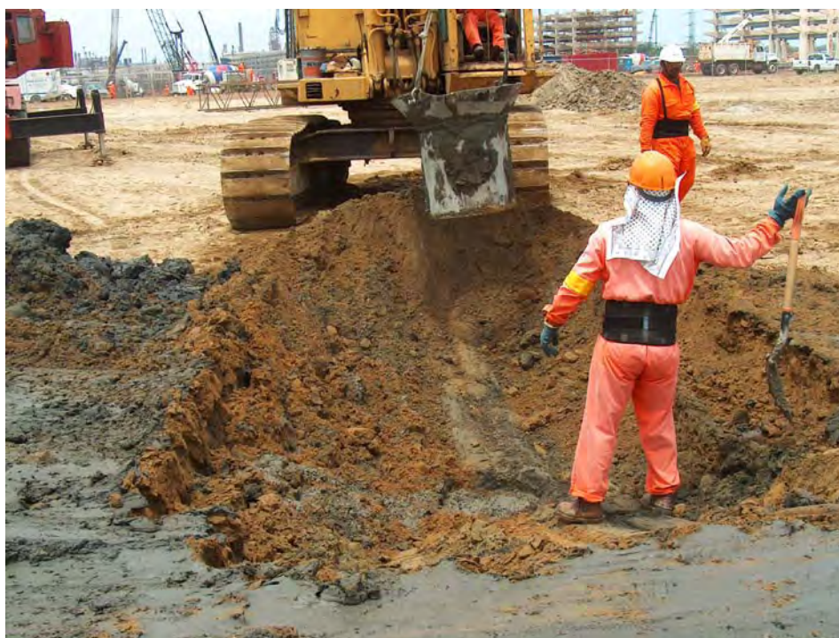
Fig. 8.27 Colocación del brocal, limpieza alrededor de la pila
