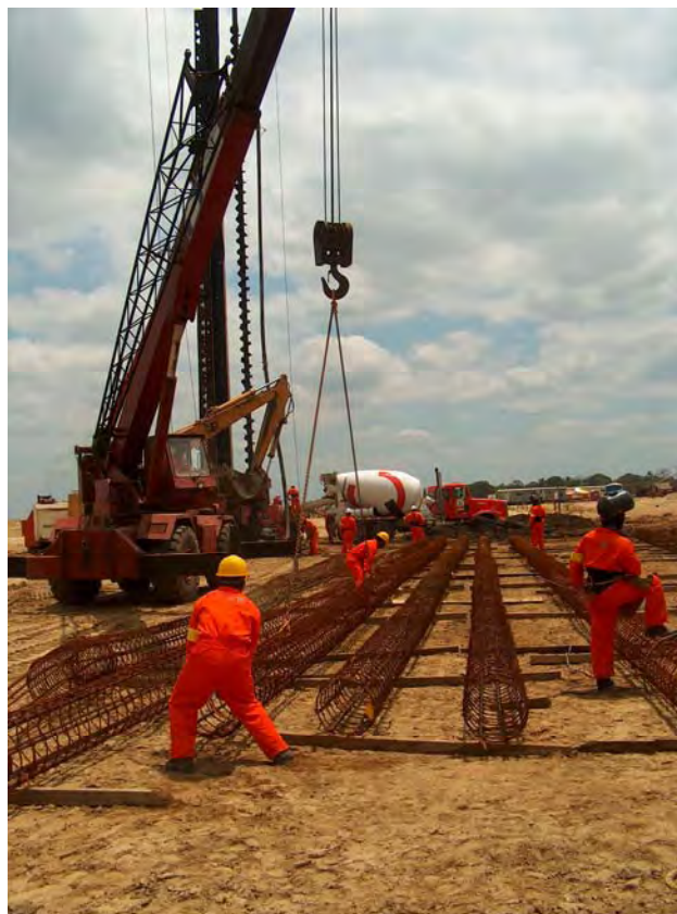
Fig. 8.13 Habilitado del acero de refuerzo, posicionamiento para izaje
