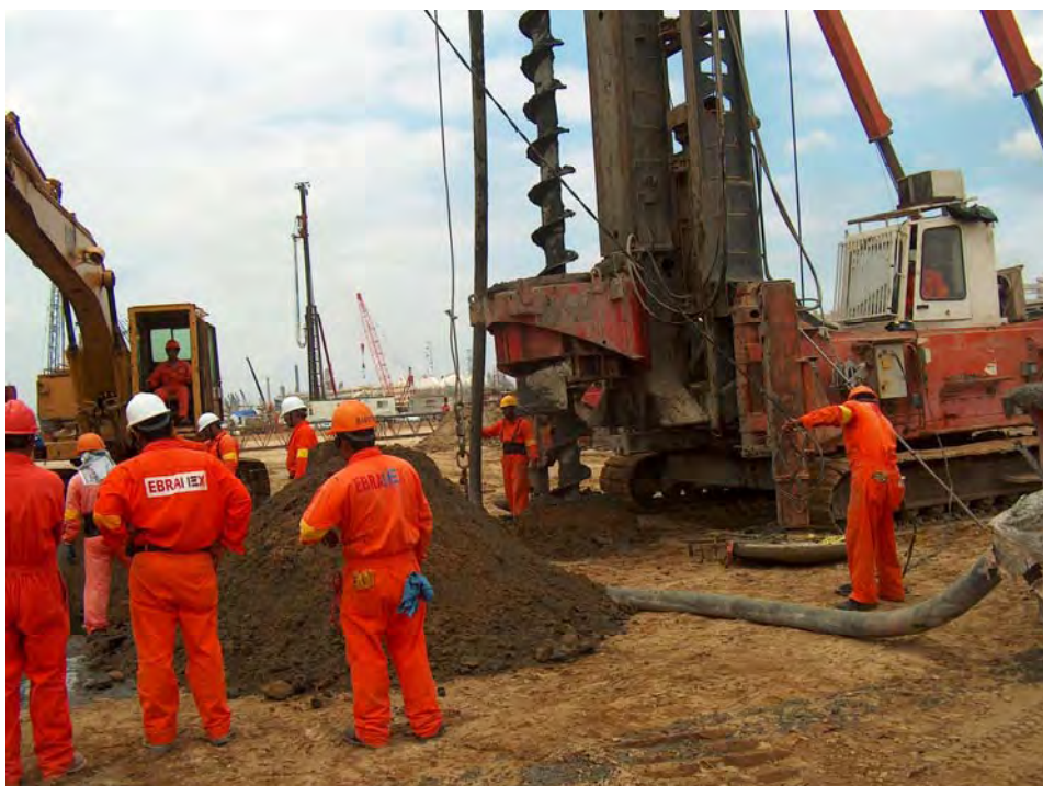
Fig. 8.16 Perforación, penetración de la helicoidal dentro del suelo
