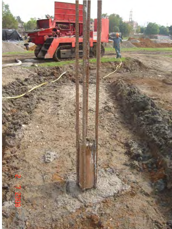
Fig. 8.40 Limpieza, pila terminada
