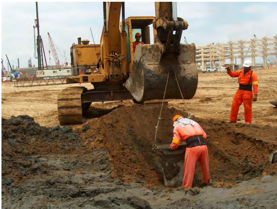
Fig. 8.29 Colocación del brocal, localización de la pila
