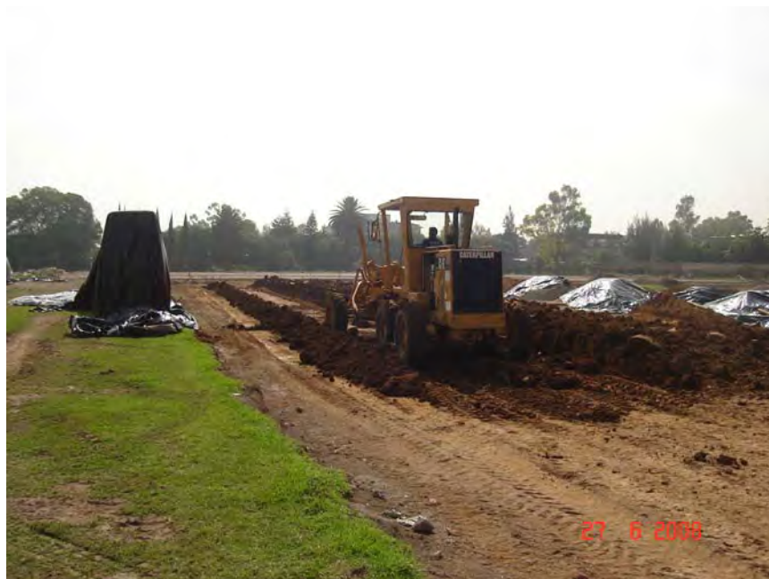
Fig. 8.1 Trabajos preliminares, mejoramiento de suelo en la superficie de trabajo
