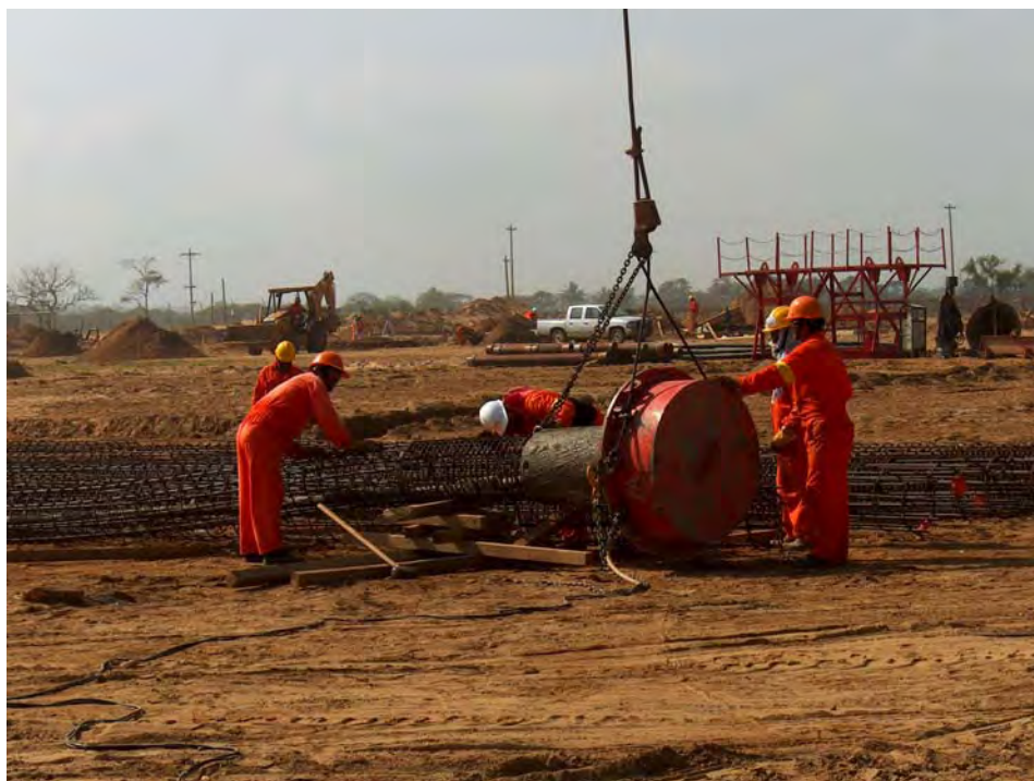
Fig. 8.25 Colocación del vibrador, acoplamiento del vibrador con el acero
