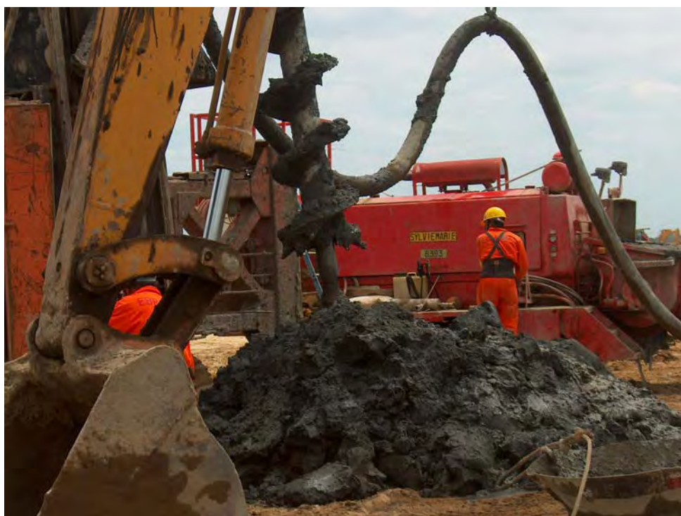
Fig. 8.22 Inyección de concreto, terminación de colado y movilización de barrena
