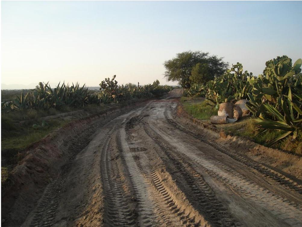
FIG. 5.1.2 CORTE DE CAJA EN TERRENO NATURAL PARA DESPLANTAR BASE GRA
