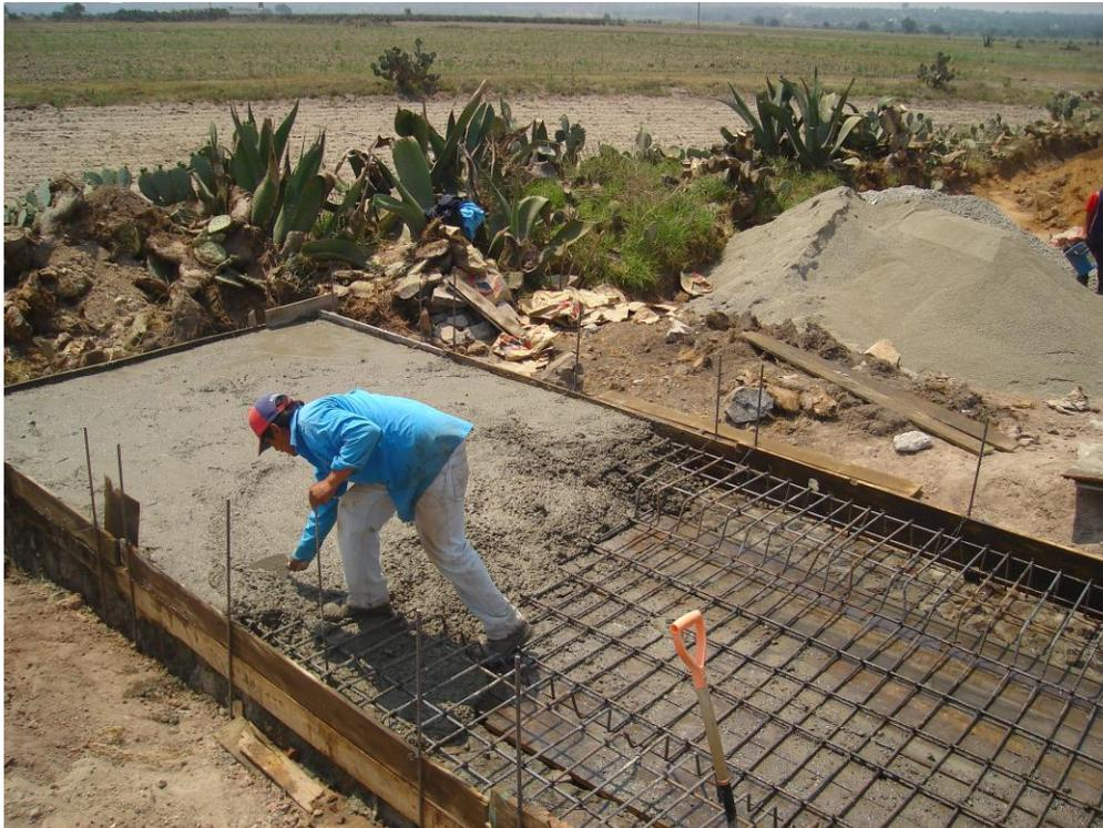
FIG. 3.7.1 CONSTRUCCIÓN DE ALCANTARILLA
