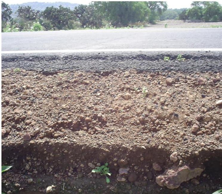
FIG. 5.7.1 PAVIMENTO FLEXIBLE SOBRE BASE CONTROLADA 70-30
