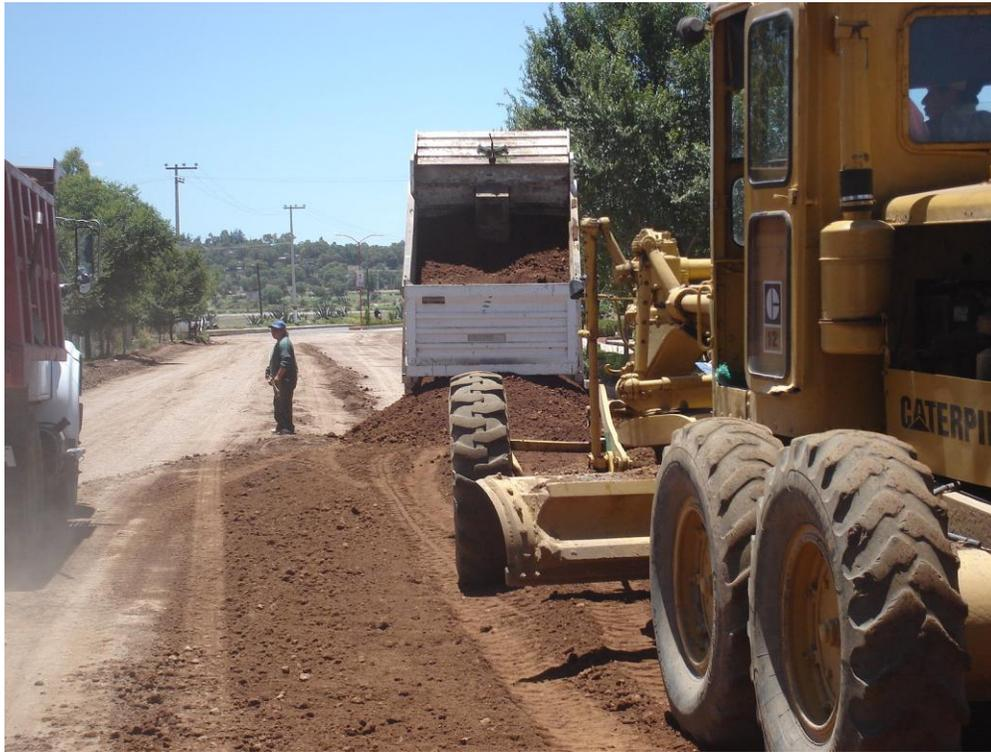
FIG. 2.1.1.1 TENDIDO DE ARENA DE TEZONTLE PARA FORMAR SUB-BASE
