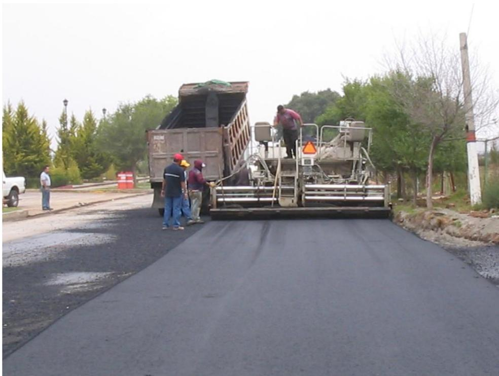
FIG 4.1.1 TENDIDO DE CARPETA ASFALTICA
