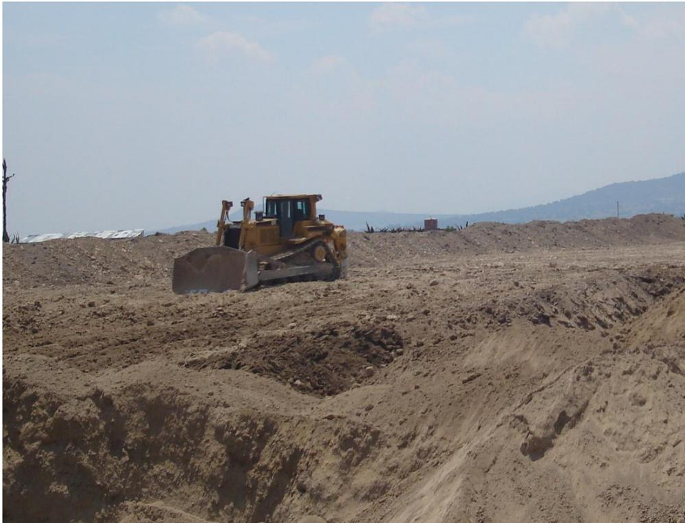
FIG. 3.3.4.1 EXCAVACION EN MATERIAL TIPO CON TRACTOR DE ORUGAS
