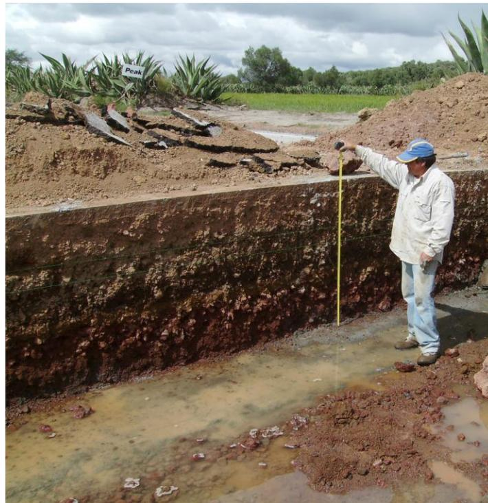
FIG. 5.1.3 SECCION TRANSVERSAL EN PAVIMENTO FLEXIBLE Y LAS TERRACERIAS
