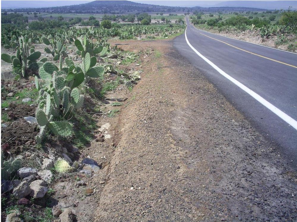
FIG. 5.7.2 CUNETA PARA DESALOJO DE AGUAS PLUVIALES
