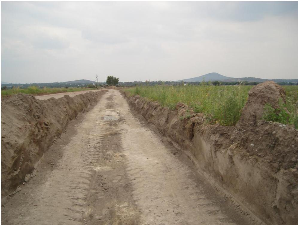
FIG. 3.3.3.1 EXCAVACION EN MATERIAL TIPO A
