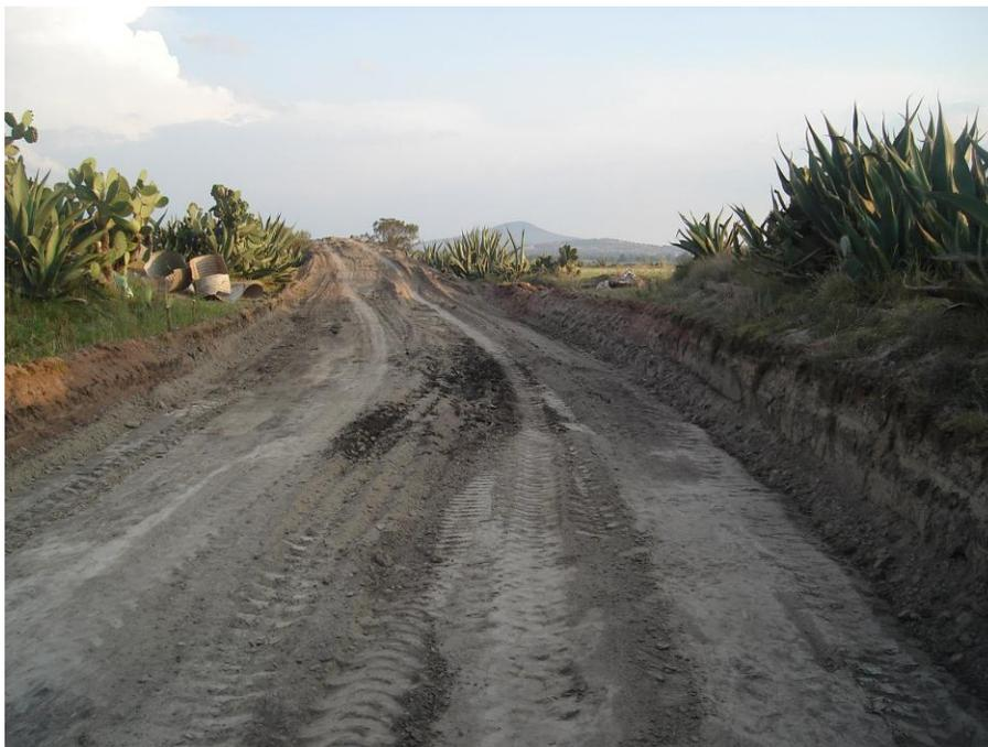
FIG. 3.1.5.1 CORTE DE CAJA EN MATERIAL ARCILLOSO
