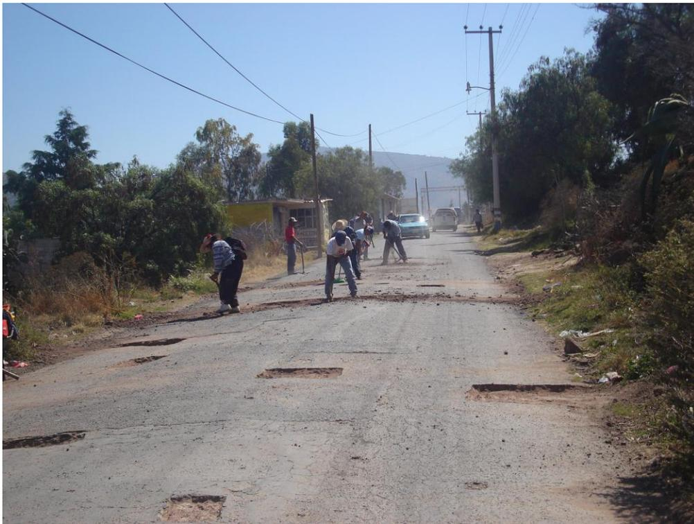
FIG. 5.7.3 BACHEO EN PAVIMENTO FLEXIBLE EN ZONA RURAL
