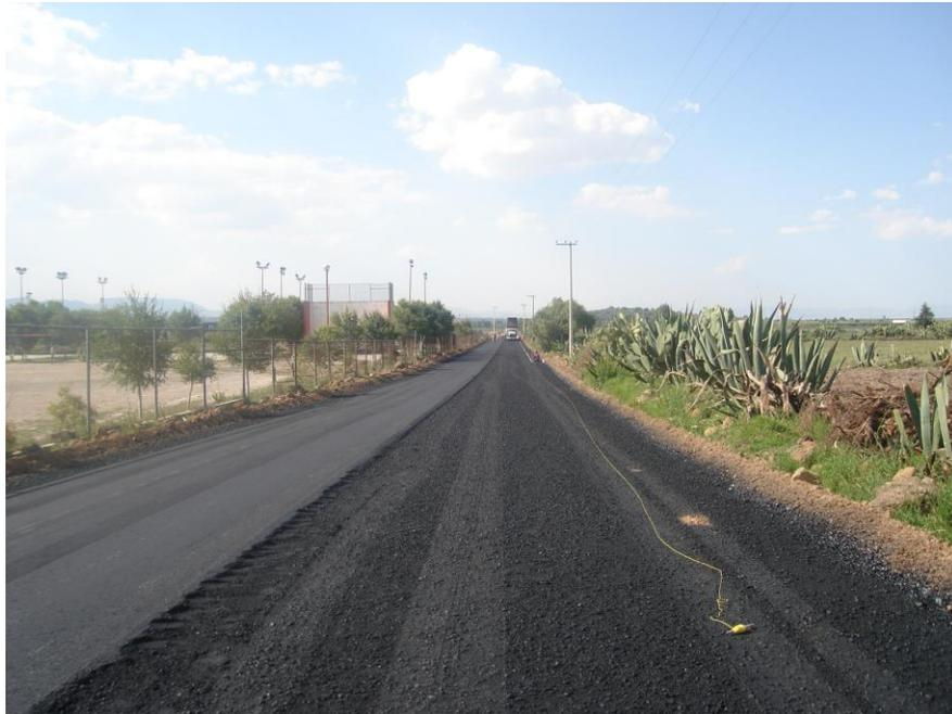
FIG. 4.3.2 TENDIDO DE CARPETA ASFALTICA
