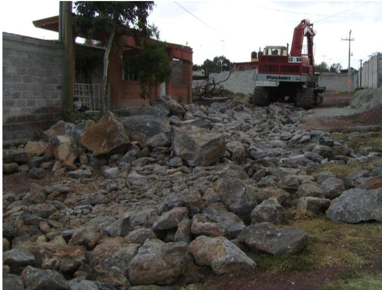
FIG. 2.1.1.4 EXCAVACION EN ROCA CON MEDIOS MECANICOS
