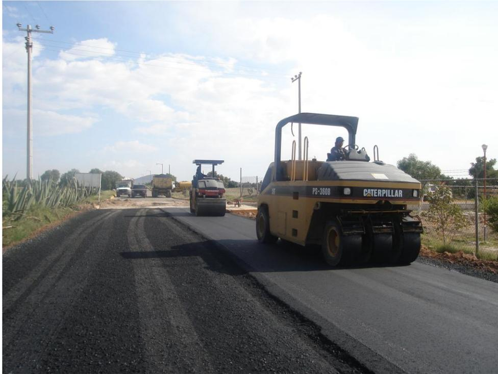
FIG. 4.3.4 RODILLO NEOMATICO Y VIBROCOMPACTADOR SOBRE CARPETA ASFALTICA
