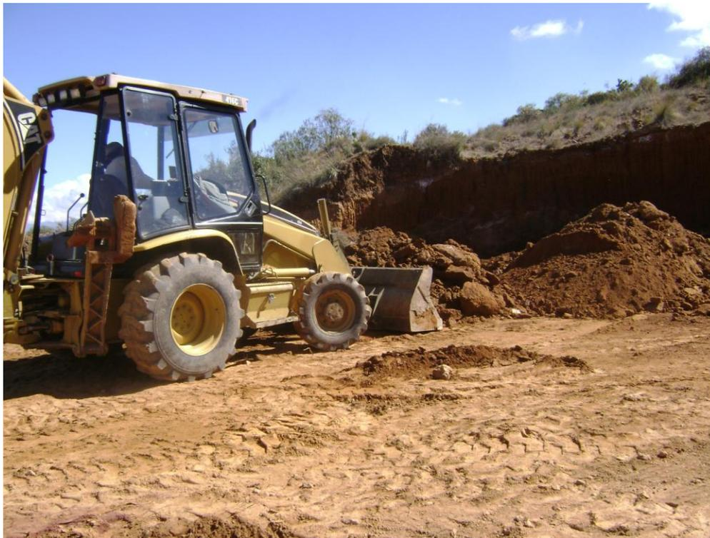
FIG. 2.1.1.3 EXTRACCION DE MATERIAL DE BANCO DE MATERIAL
