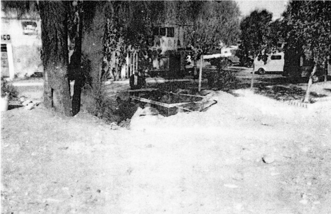
Fotografía No 1. Panorámica de la Cala 01 en una de sus etapas.
