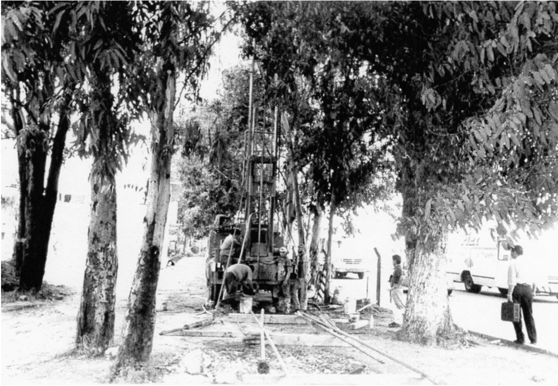
Ejecución del Sondeo 4.
