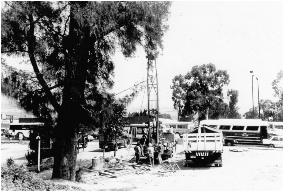
Ejecución del sondeo 3 y de la instalación de la estación piezométrica.
