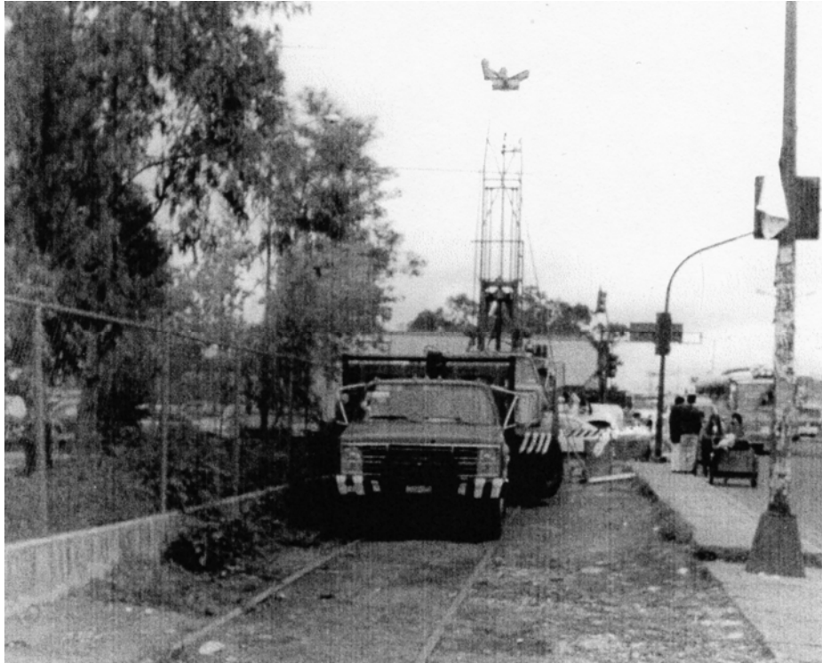
Ejecución del sondeo 2.
