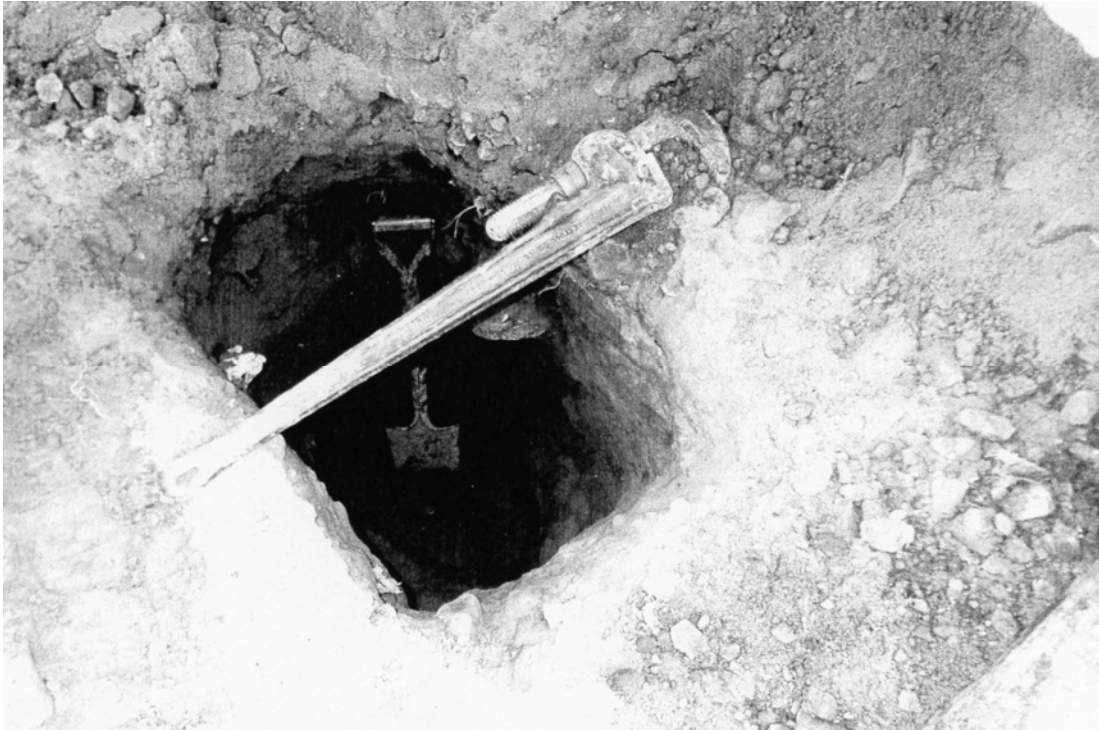
Calas tipo realizadas (cala1), para verificación de instalaciones.
