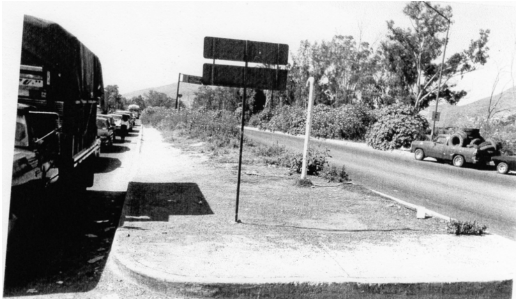
Aspectos del cruce, mostrando las señales de las instalaciones de Pemex, ubicadas en las dos vialidades
