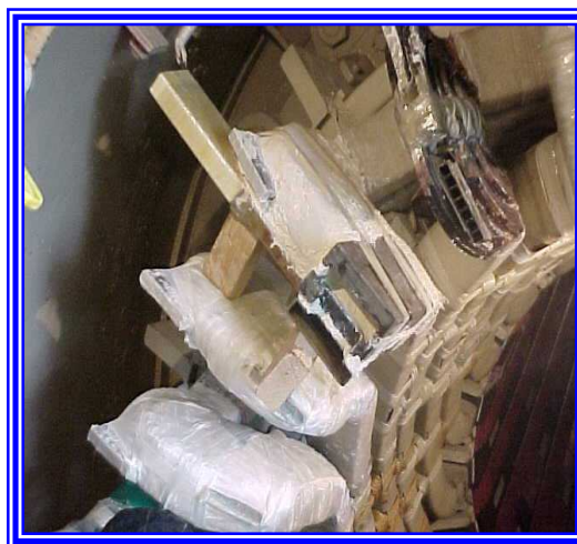
Fotografías 5.44 y 5.45 Colocación RDT'S
