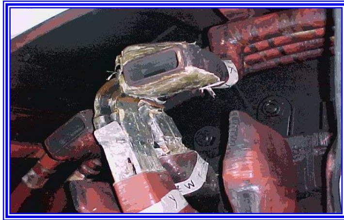
Fotografía 5.1 Cabezal desencintado.
