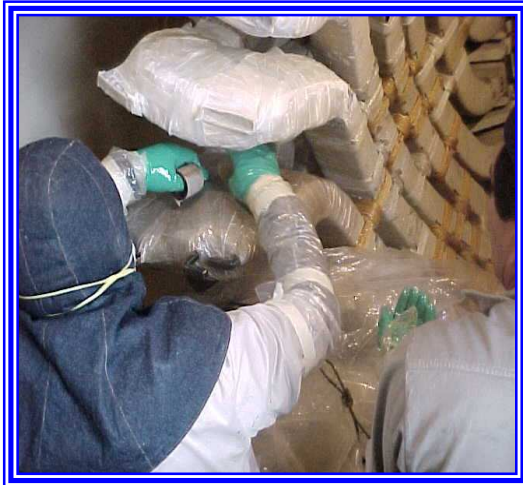
Fotografía 5.42 y 5.43 Aplicación de cinta termocontractil a cabezal
