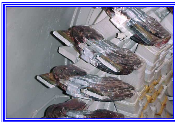
Fotografía 5.37 Conector sin cinta verificando la aplicación de la soldadura
