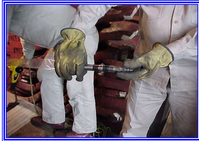
Fotografía 5.6 Presurización de manguera
