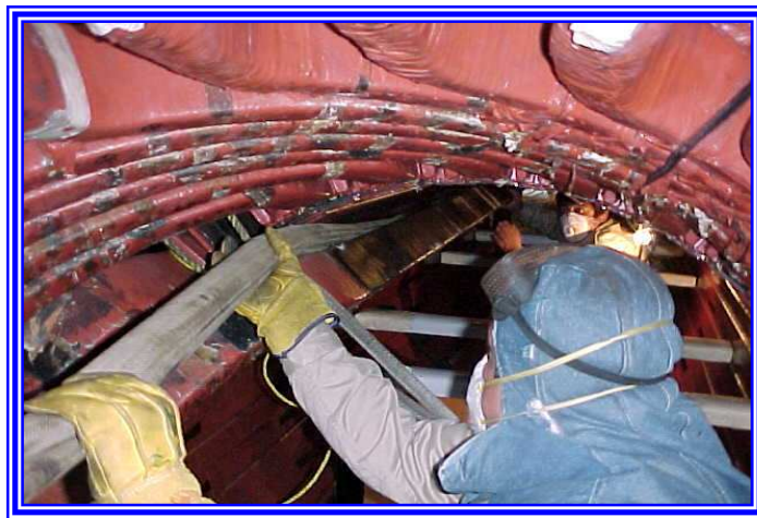
Fotografía 5.7 Manguera contra incendio
