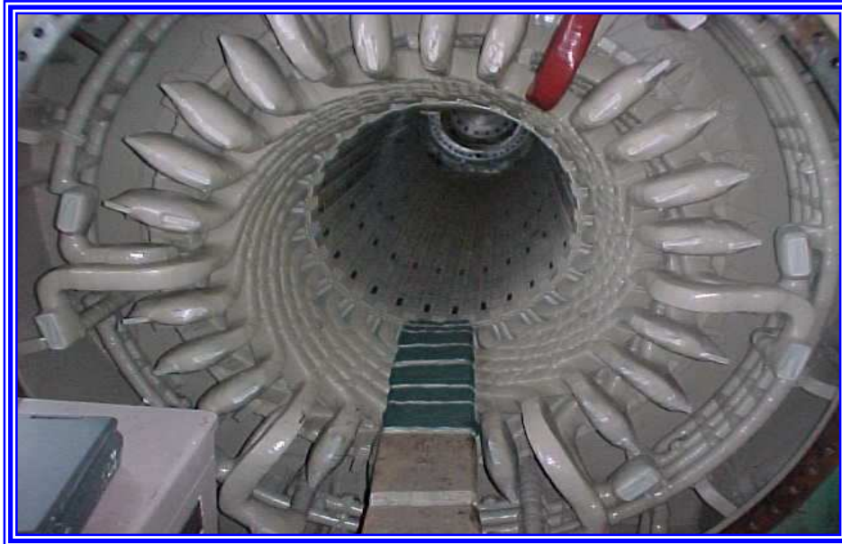
Fotografía 5.45 Acabado final del estator con barniz aislante
