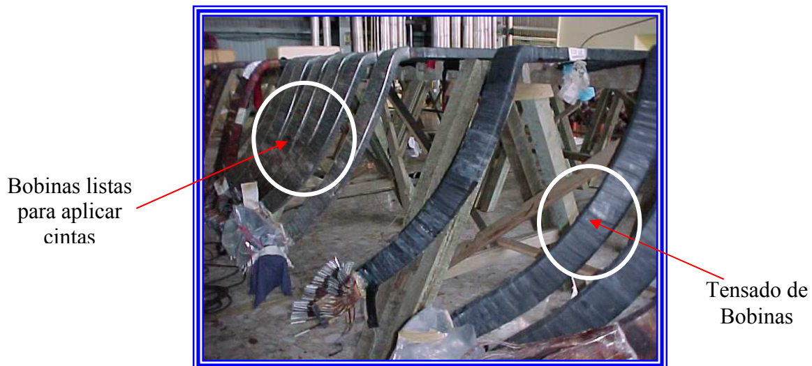
Fotografía 5.28 Bobinas tensadas con cámara nueva para lograr que las cintas se adhieran correctamente a la bobina
