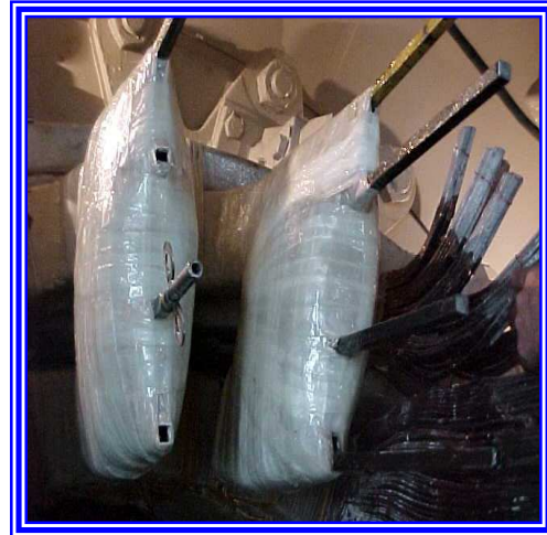
Fotografía 5.42 y 5.43 Aplicación de cinta termocontractil a cabezal
