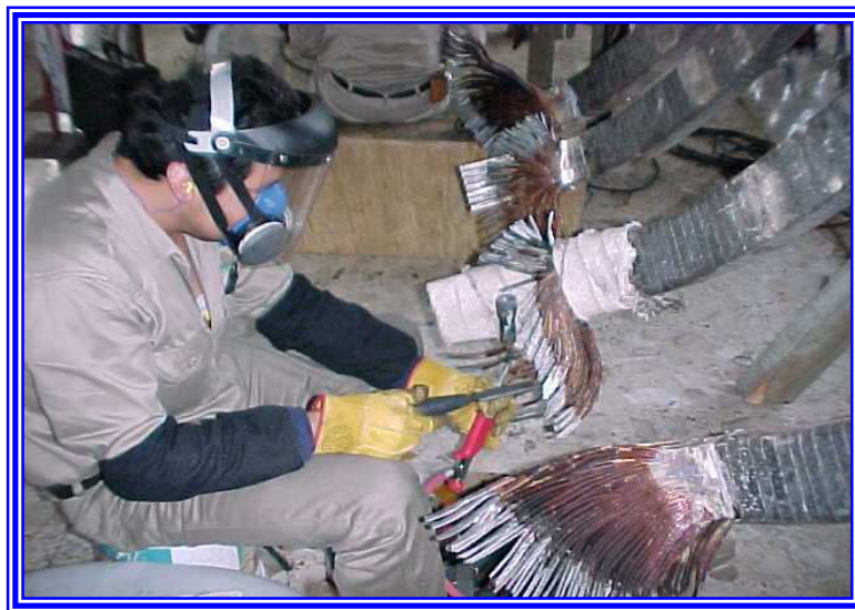
Figura 5.24 Limpieza de soleras de los cabezales de las bobinas
