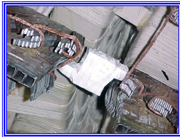
Fotografía 5.35 Conector cubierto con cinta fibra de vidrio
