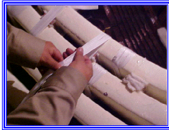
Fotografía 5.20 Amarres entre bobinas y cabezales
