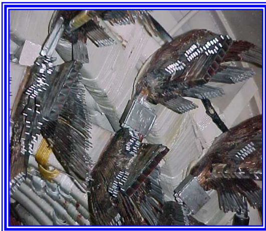
Fotografía 5.33 Reparación de conexiones
