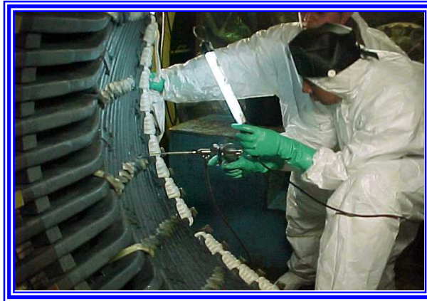
Fotografía 5.21 Aplicación de resina al cordón de fibra de vidrio
