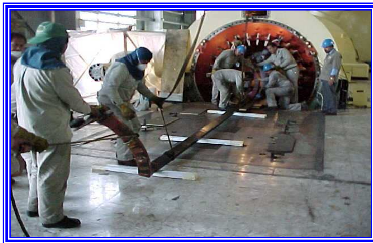
Fotografía 5.8 Extracción de bobinas
