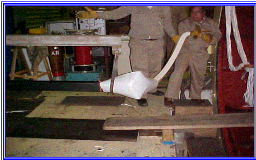
Fotografía 5.13 Inserción de bobina con ayuda de la grúa
