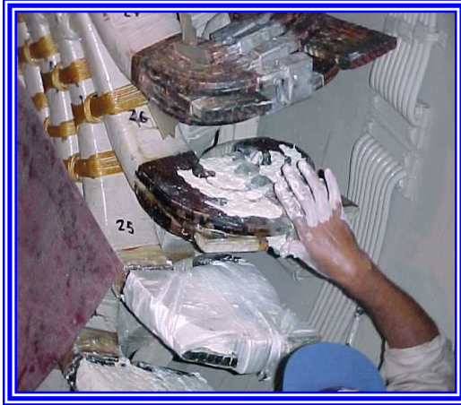
Fotografía 6.41 y 6.42 Relleno de los cabezales con masilla y recubrimiento de con cinta para que ajuste
