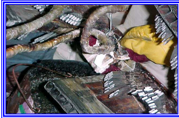
Fotografía 5.36 Calentamiento del conector
