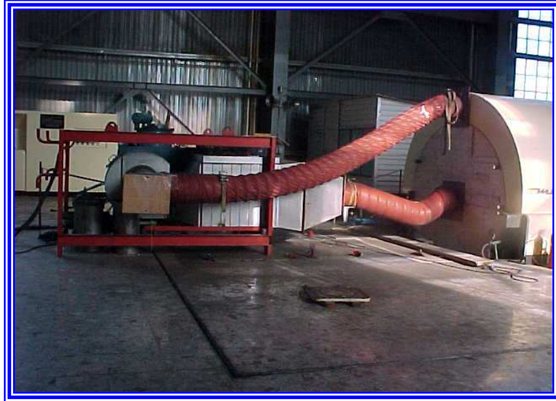
Fotografía 5.46 Secado del estator del generador eléctrico
