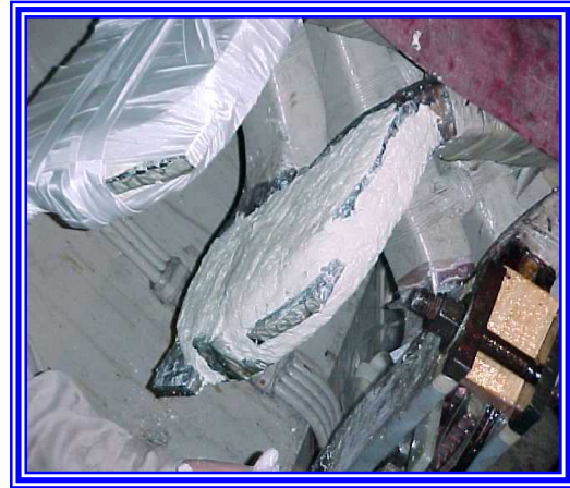
Fotografía 6.41 y 6.42 Relleno de los cabezales con masilla y recubrimiento de con cinta para que ajuste
