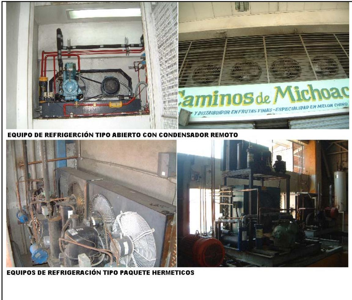
**Fig. 4.3 Equipos típicos de refrigeración.**
