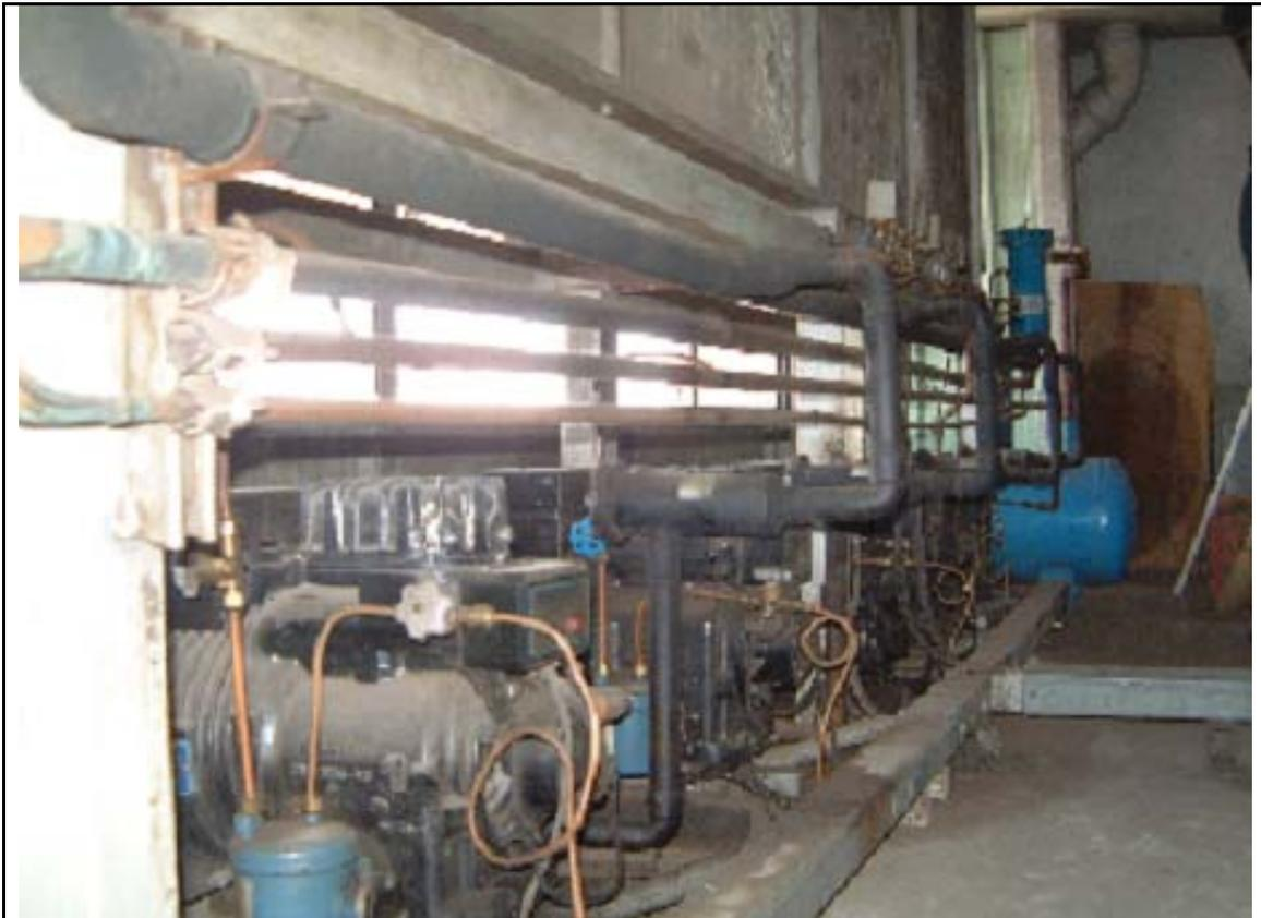
Fig. 4.4 Equipo de refrigeración con compresores en paralelo.
