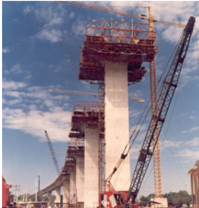
Fig. No.2.- Subestructura de un puente.
