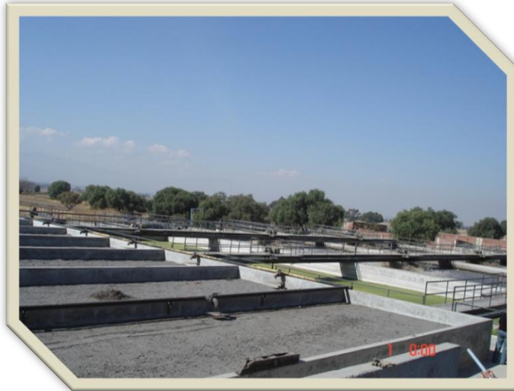
Fig.6.4. Planta de tratamiento 4 Vientos.
