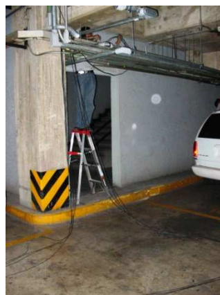
Figura 3.46. Colocación de cable coaxial de acometida.
