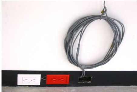
Figura 3.36. Apariencia los contactos de corriente normal (blanco) y regulada (rojo).
