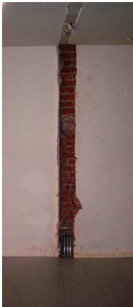
Figura 3.12. Panorama de las paredes del primer piso.
