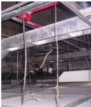
Figura 3.17. Vista arriba de los plafones del clóset de sexto piso.
