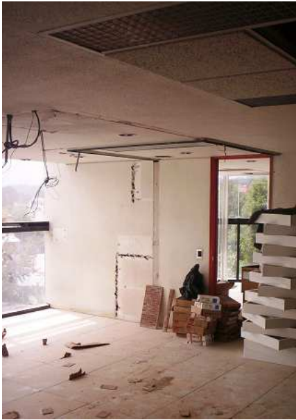
Figura 3.10. Panorama inicial del área de trabajo del sexto piso.
