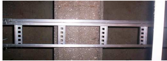
Figura 3.15. Vista escalerilla arriba del plafón del clóset de primer piso.
