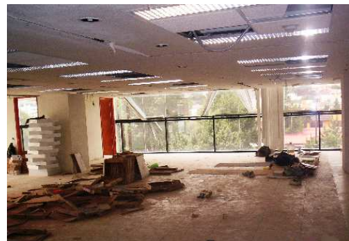
Figura 3.9. Apariencia general del área de trabajo del primer piso.
