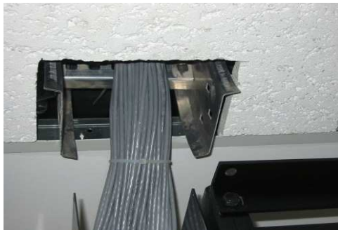
Figura 3.34. Ingreso del cableado de datos a la escalerilla del plafón.
