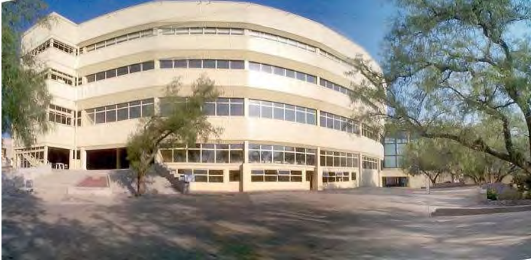
(VISTA FRONTAL DEL AUDITORIO DEL CCC)
