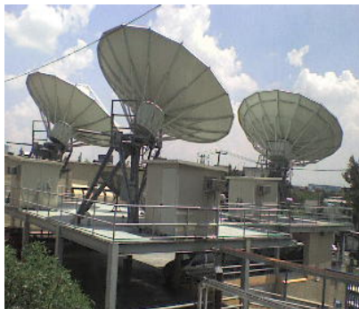
Fig.4.28 Antenas tipo Cassegrain de 7.6 metros de diámetro
