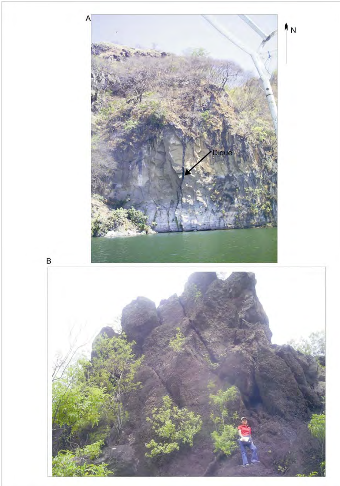
Figura 23. A) Diques con orientación N-S afectando paredes del Maar Asososca. B) Cono de escoria afectado por estructuras sigmoides en posición vertical con tamaños de hasta 3 m (Segmento Central).
