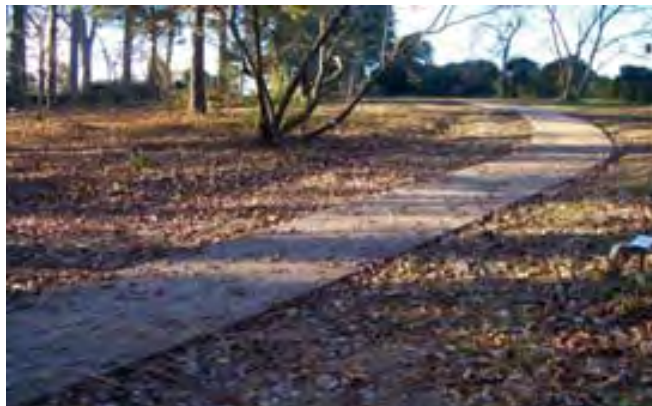
Figura 1.4 Acumulación de finos y material vegetal ( https://fp.auburn.edu/heinmic/PerviousConcrete/ ).
