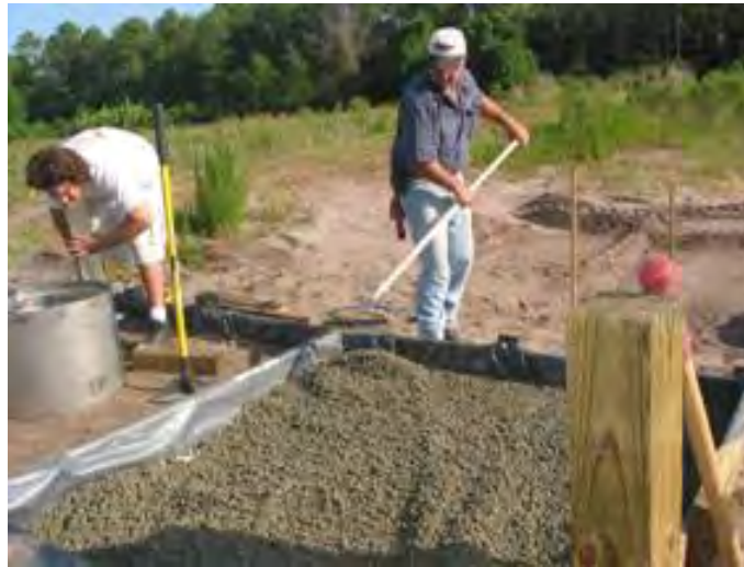
Figura 4.3 Rastrillado del concreto permeable a una elevación aproximada. ( http://www.stormwater.ucf.edu/research/previous_concrete_pavement_research_files/image005.jpg ).
