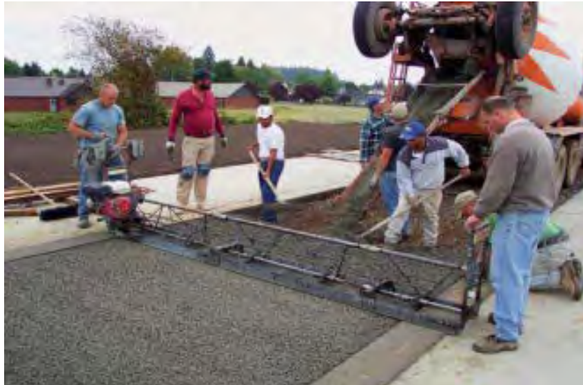
Figura 4.2 Colocación del concreto permeable por medio de un camión mezclador con descarga por atrás (Tennis et al., 2004)
