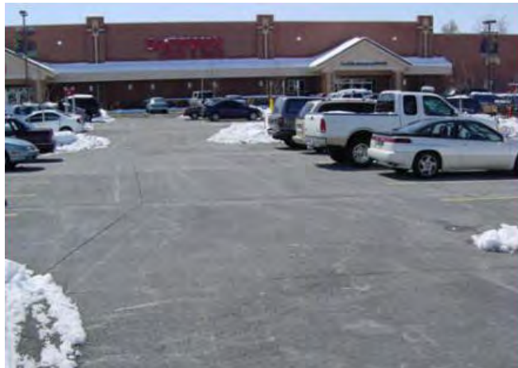
b. Superficie con concreto permeable
