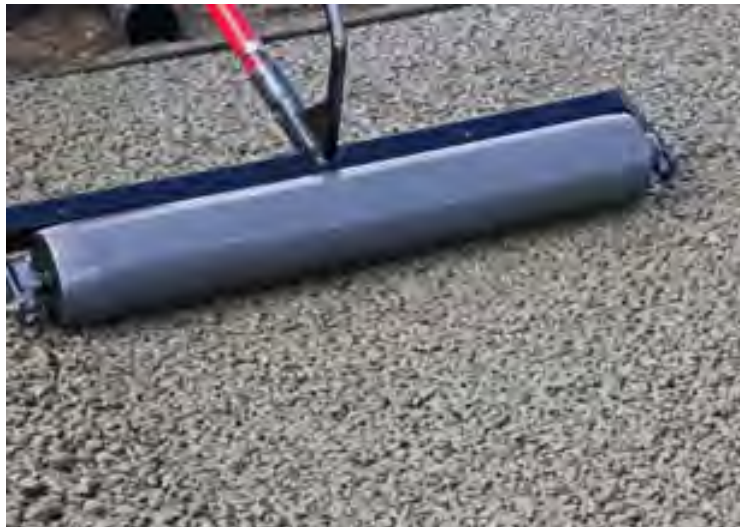
Figura 4.8 Rodillo pequeño usado para compactar una área pavimentada pequeña ( http://www.perviousconcrete.com/images/build07/cert_pervious_roller.gif ).
