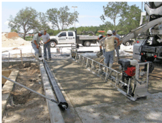
Figura 4.6 Enrasado del concreto permeable mediante el uso de una enrasadora vibratoria de marco con sección tipo “A” ( www.perviousconcrete.com ).
