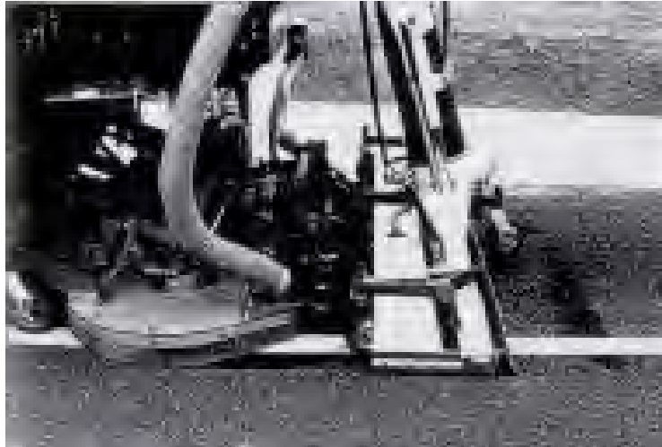
Figura 4.11 Máquina autopropulsada de limpieza con sistema presión-aspiración (De Solminihac et al., 2002).
