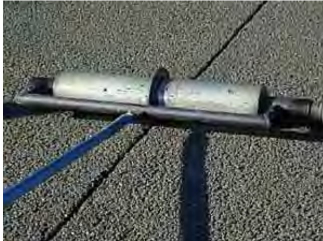
Figura 4.9 Construcción de una junta mediante la adaptación de una hoja en el rodillo de compactación ( http://www.ctre.iastate.edu/Research/project_photos/pervious_joint.jpg ).
