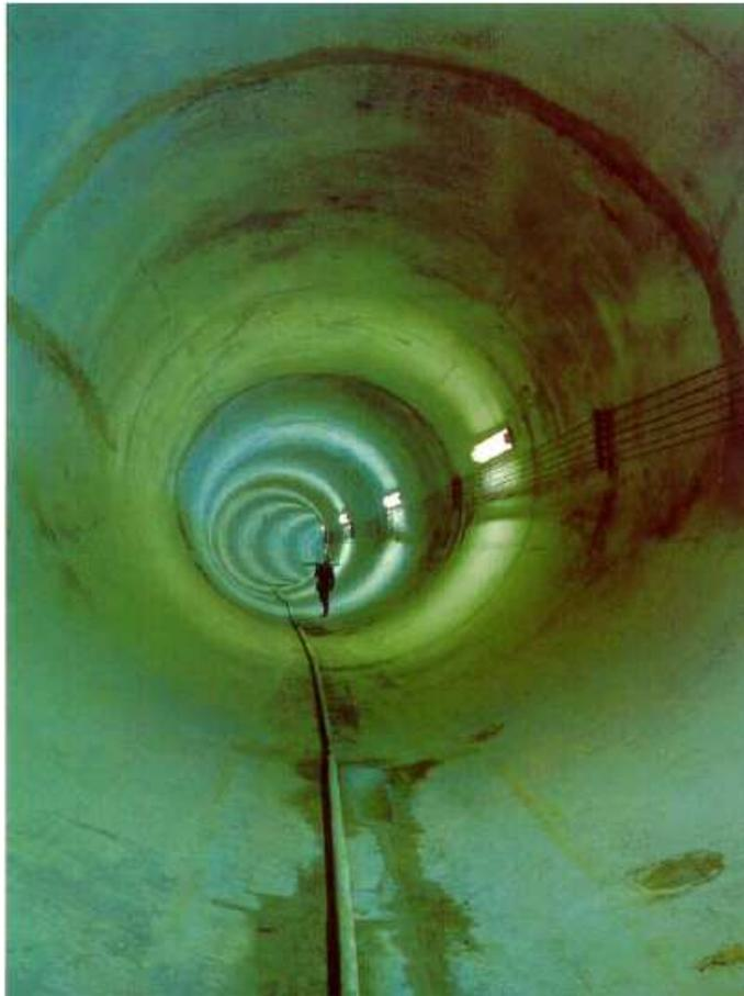
**Figura 3.5. Sistema de drenaje profundo (Emisor Central).<sup>18</sup>**
