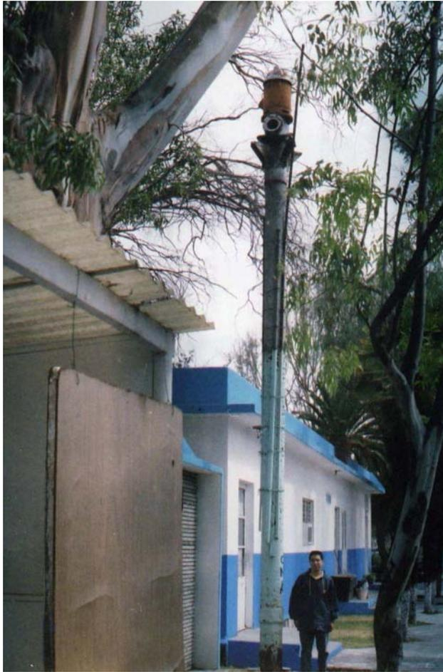
**Figura 4.2. Hundimiento del terreno ocasionado por la extracción de agua del subsuelo por bombeo observado en el lago de Texcoco de más de 7 m.**
