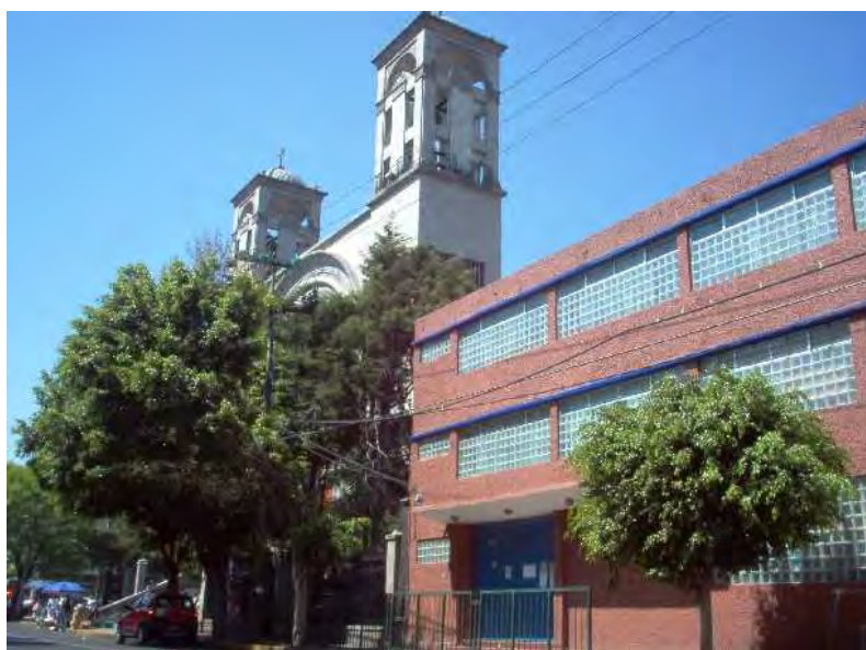
Figura 3.1 Fachada posterior del colegio Fray García de Cisneros sobre la avenida de los Insurgentes.
