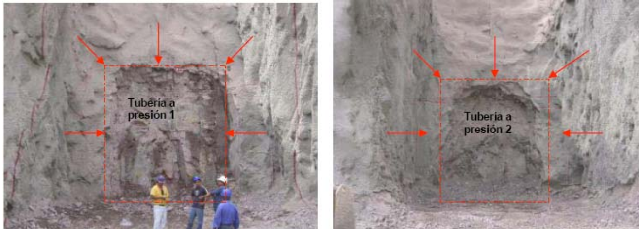
Fotografía IV.2.- Inicio de la excavación de las dos tuberías a presión en su sección rectangular por la obra de toma
