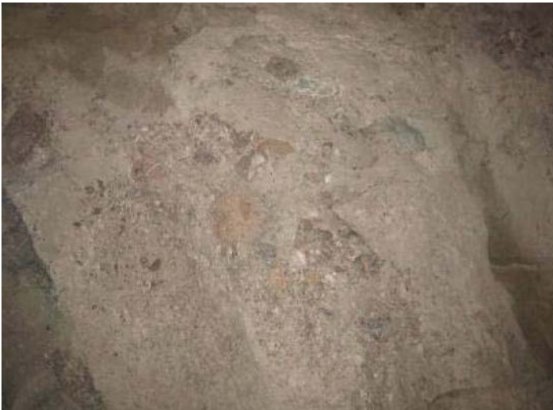
Fotografía IV.5.- Vista de la tubería a presión 1 en el cadenamiento 0+060,00 donde se observa con detalle las características del horizonte aglomerático inferior de la fase de la ignimbrítica de la unidad TicU2.
