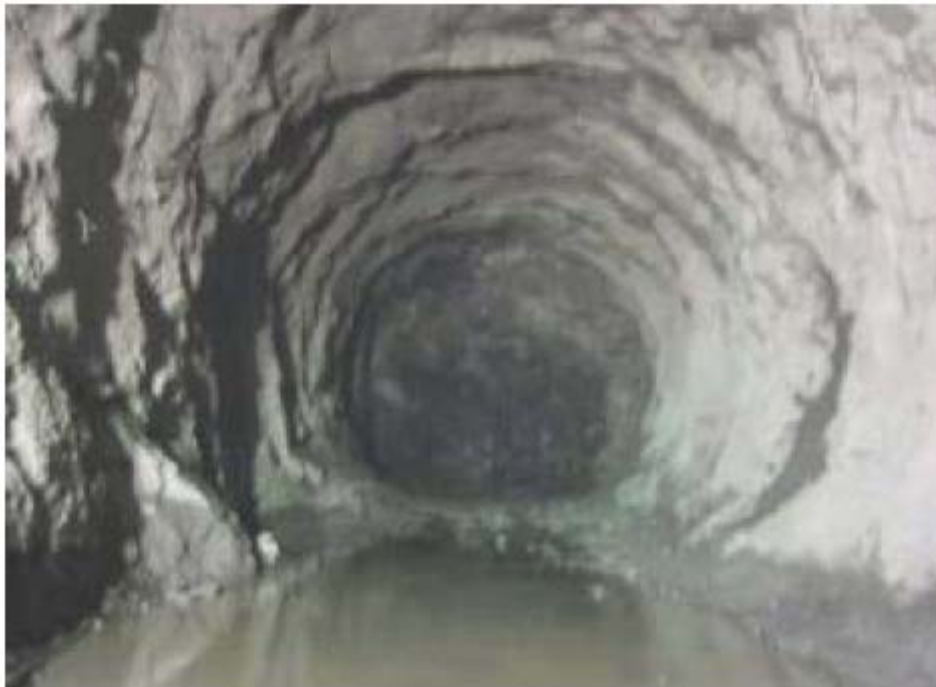
Fotografía IV.1.- Tramo de la excavación horizontal de la tubería a presión No.1.
