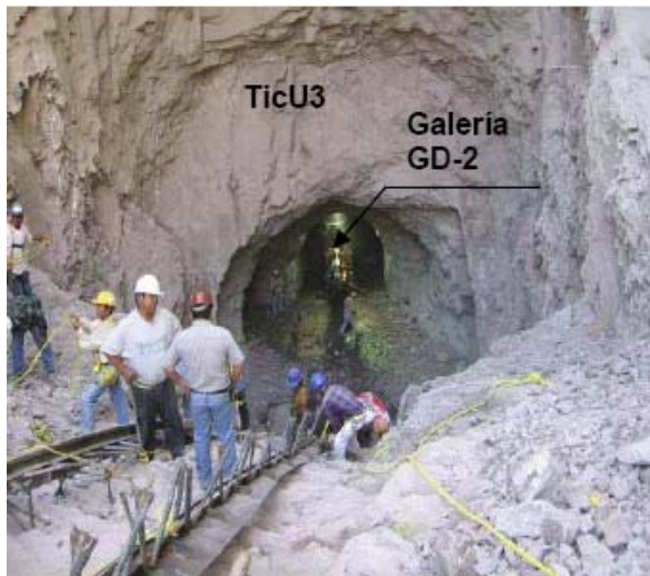
Fotografía No. IV.4 Vista de la excavación de las dos tuberías en el codo superior, donde se observa las características de la roca, al fondo la conexión con la galería GD-2.
