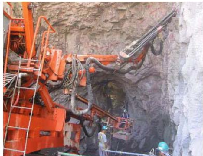
Fotografía No. IV.4 Vista de la excavación de las dos tuberías en el codo superior, donde se observa las características de la roca, al fondo la conexión con la galería GD-2.
