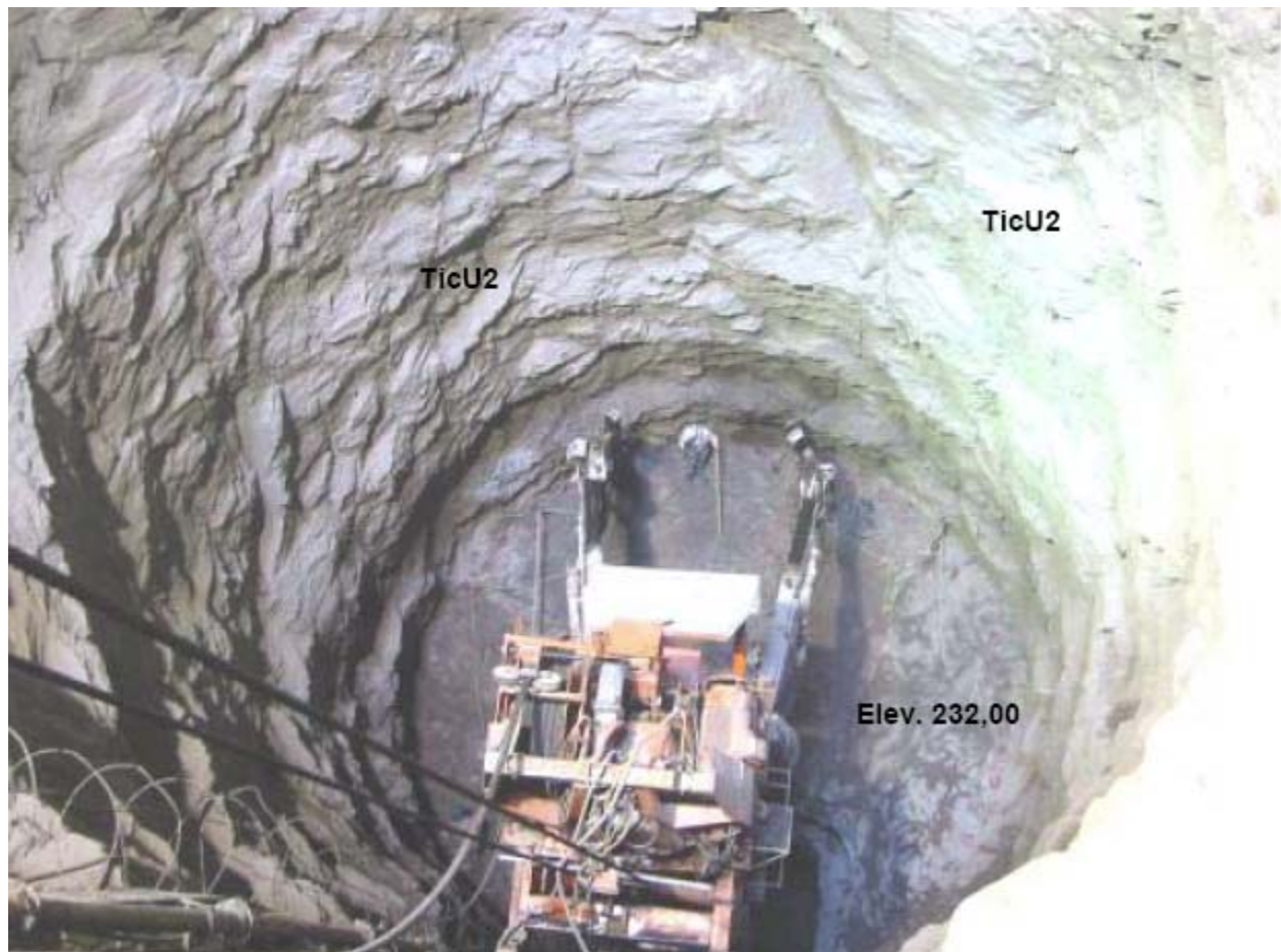
Fotografía IV.3.- Vista de la excavación del tramo inclinado de la tubería a presión 1 a la elevación 232,00.
