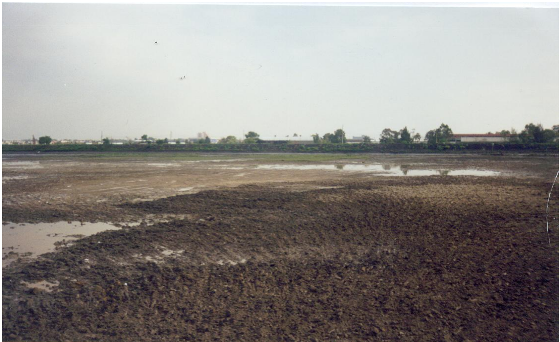
PANORAMICA DE CONCLUSIÓN DE LOS TRABAJOS DE DESAZOLVE
