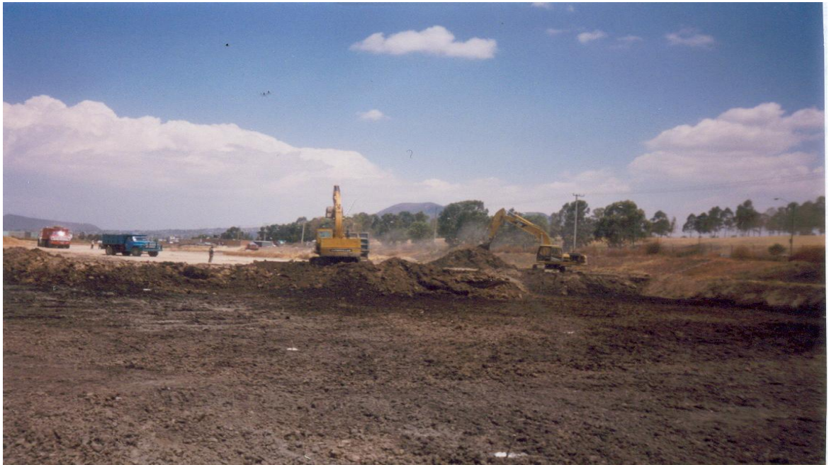
CARGA Y ACARREO EN CAMION DEL AZOLVE DESHIDRATADO DE LA LAGUNA.
