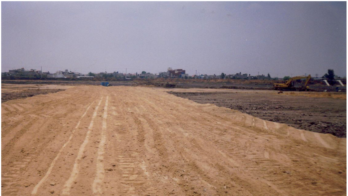
CONFORMACIÓN DE CAMINO DE ACCESO Y PEINES DE PENETRACIÓN AL VASO DE LA LAGUNA
