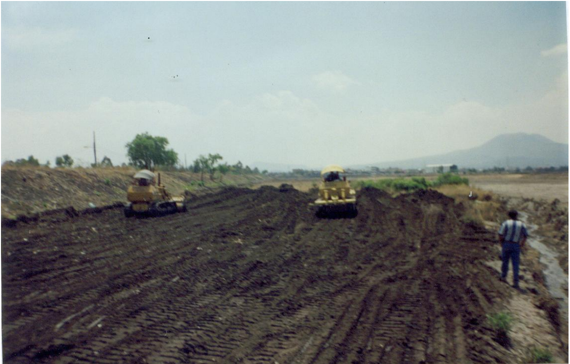
Corte y arremangue de material formando bancos para su posterior carga a camión.
