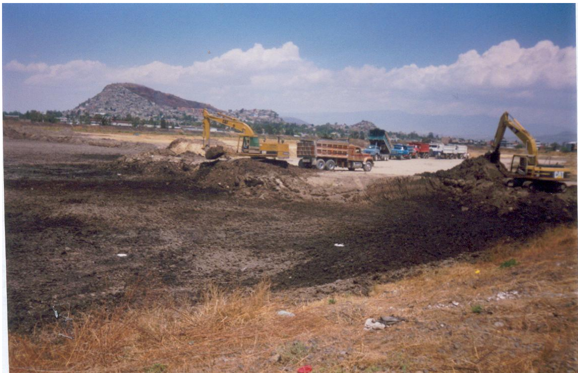
CARGA Y ACARREO EN CAMION DEL AZOLVE DESHIDRATADO DE LA LAGUNA MAYOR
