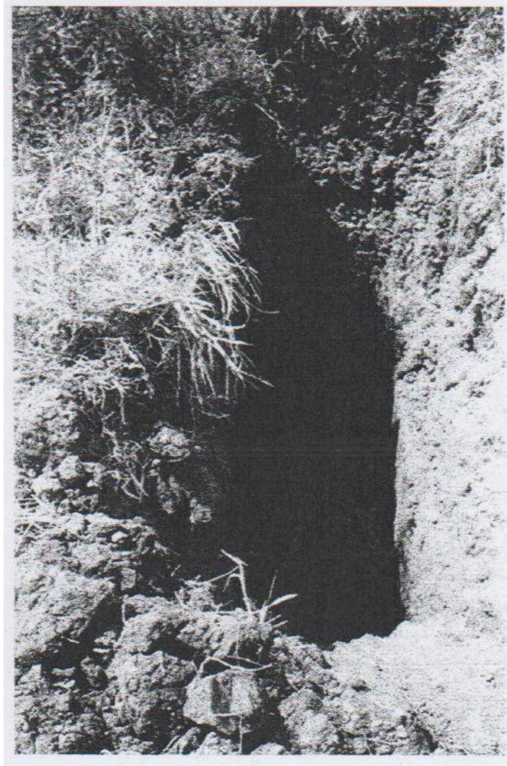
FOTO 26 VISTA DE LA ESTRATIGRAFIA DEL PCA-7, DONDE SE EXCAVO BSSTA 3.00 M, DE PROFANDIDAD, EL NAF NO SE DETECTO.
