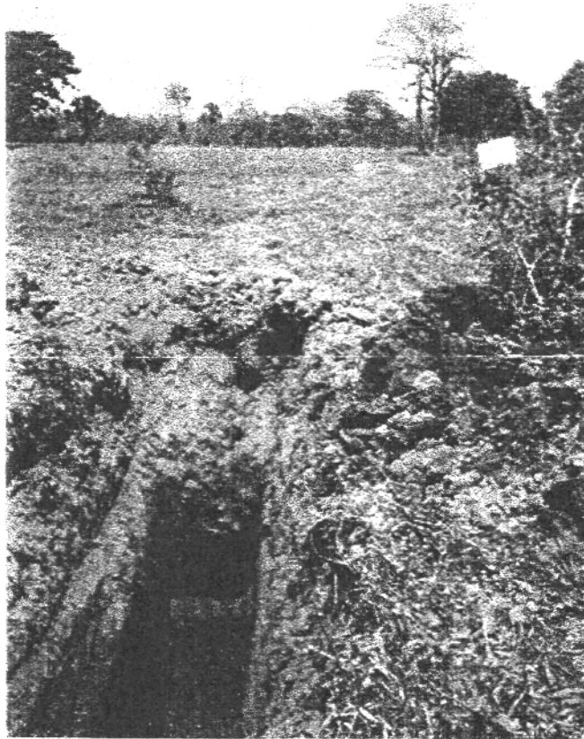
FOTO 13 VISTA DE LA ESTRATIGRAFÍA DEL PCA-3, DONDE SE EXCAVO HASTA 3.20 M. DE PROFUNDIDAD, EL NAF SE DETECTO A 2.55 M.
