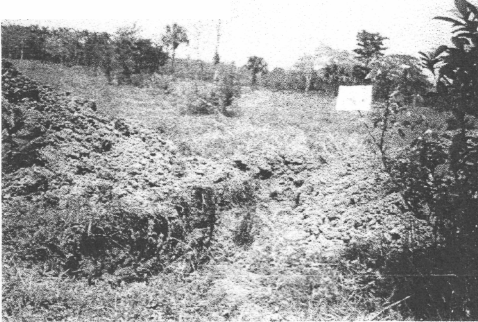
FOTO 16 EXCAVACIÓN DEL PCA-4 CON RETROEXCAVADORA.
