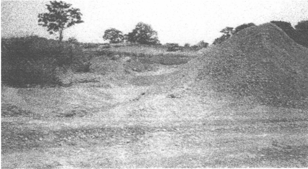
FOTO 43 BANCO SAMARIA. UBICADO EN CARRETERA VILLAHERMOSA-TEAPA KM. 132+220, DESVIACIÓN DERECHA 300 M. CON MATERIAL PARA BASE HIDRÁULICA V SUB-BASE.
