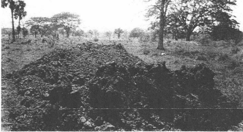
FOTO 20 VISTA DEL PCA – 5 AL PCA – 6
