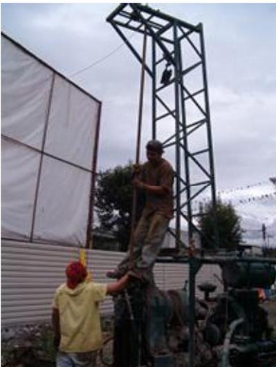
Colocación del cono electrico dentro de la perforación.
