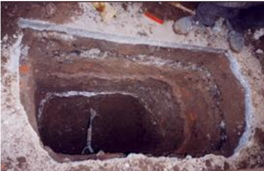
Avance de la excavación del PCA # 2, en colindancia con la entrada a la calle de Yácatas, en el cual se encuentra una segunda losa de piso, con varias capas de materiales de relleno.
