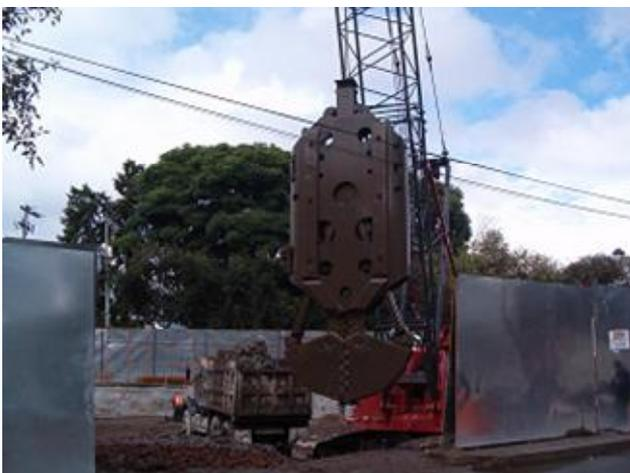
Continuación de los trabajos de retiro de material de la perforación, realizados con la almeja.
