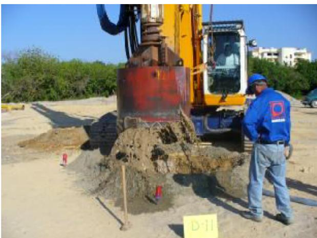
Continuación de la perforación de la pila.
