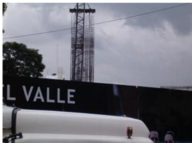
Inicio del izado del acero de refuerzo del muro milán, listo para ser introducido en la perforación ya concluida.
