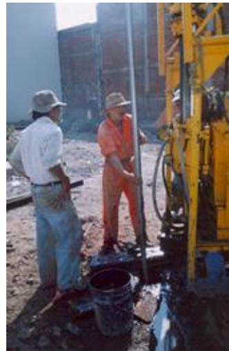
Colocación de la tubería necesaria para la realización del sondeo mixto.
