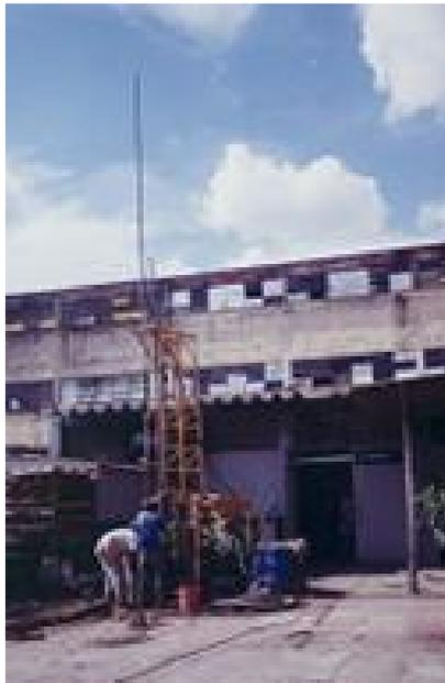
Colocación del tubo partido, observe el avance que se lleva con la tubería dividida en dos partes, para no tener un accidente en el momento de la colocación.
