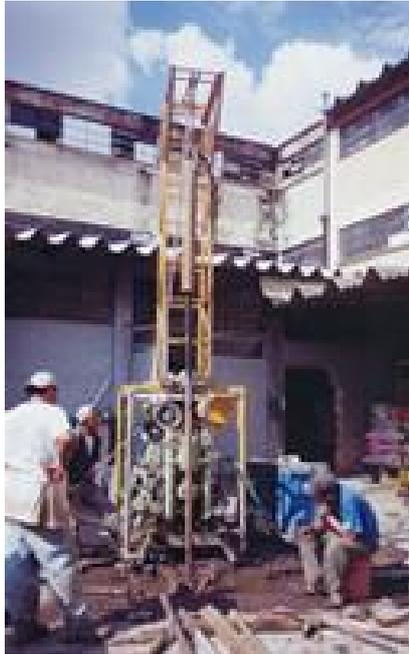
Momento en el que es marcado la tubería, para realizar la penetración a base de un golpeo constante con el martínata.
