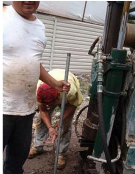
Acoplamiento de la tubería, para bajar a nivel de proyecto.
