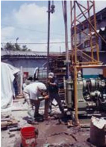
Colocación del tubo Shelby para ser introducido en la perforación.
