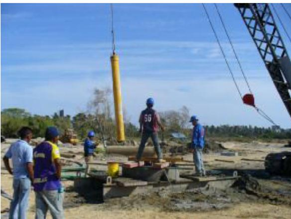
Inicio de la colocación de la tubería tremie.
