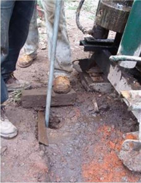
Introducción de la punta piezométrica junto con la tubería.
