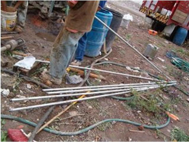
Vista de la tubería que se utilizara para realizar la punta piezométrica.
