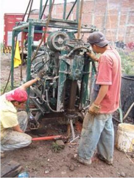
Colocación de la perforadora, la cual realizara el sondeo de cono eléctrico.
