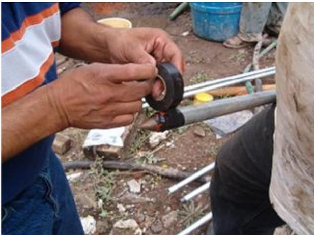
Momento que se efectua el acoplamiento de la punta piezométrica con ta tubería.
