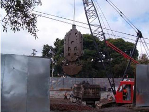
Vista de la almeja la cual vaciara el material producto de la perforación en el camión.
