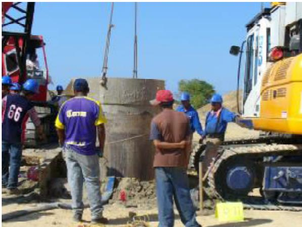
Inicio de la colocación del ademe metálico en la perforación.
