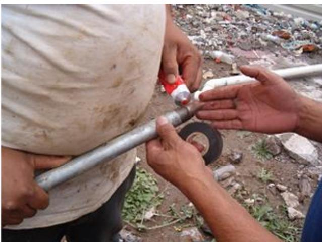
Momento que que se efectua el acoplamiento de la punta piezométrica con ta tubería.
