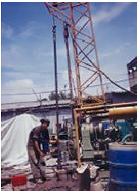
Broca triconica utilizada, para que la perforación tenga un diámetro de 10-cm, y así pueda penetrar sin ningún problema el tubo Shelby.
