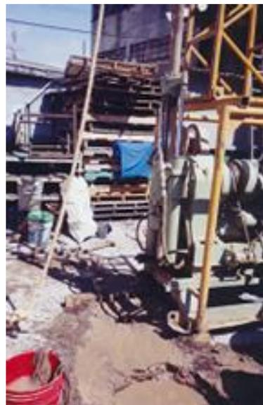
Vista de la perforación y utilización de betonita para estabilizar la perforación.
