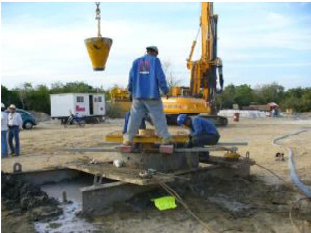
Termino del colado de la pila e inicio del desacoplamiento de la tubería tremie.
