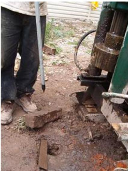
Momento en que la punta piezométrica será introducida en la perforación.
