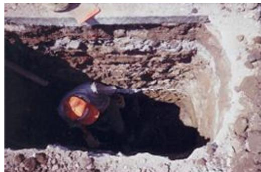
Avance máximo de la excavación del PCA # 2, en el cual se encuentra el material sano.
