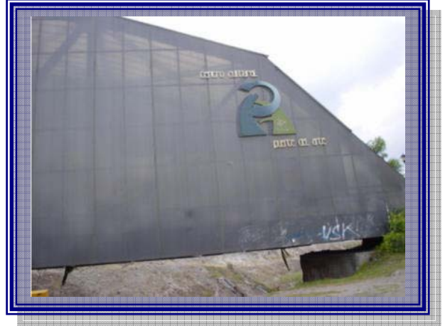
El puente de hierro, construido en 1940 y que servía para el paso del ferrocarril, hace 4 años fue remodelado y ahora es un espacio dedicado al arte.
