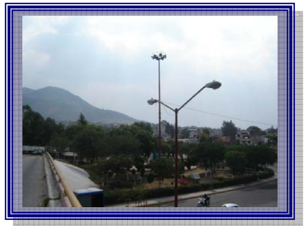
SUPERPOSTE CRUCE CARRETERA
