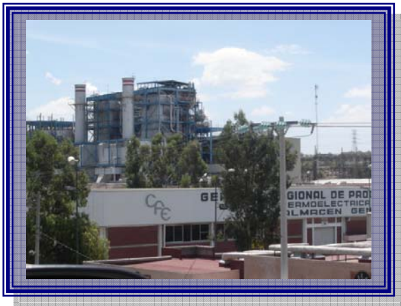
TERMOELÉCTRICA VENTA DE CARPIO (C.F.E.)
