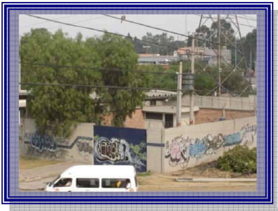
POZO DE AGUA POTABLE, A CARGO DE LA DGOH AMERICAS "
