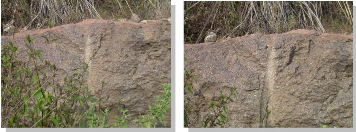
Rastro de los barrenos que se utilizaron para hacer y ampliar el camino por donde salió Chalchiuhtlicue, 2007. Foto: Georgina Ramos.
