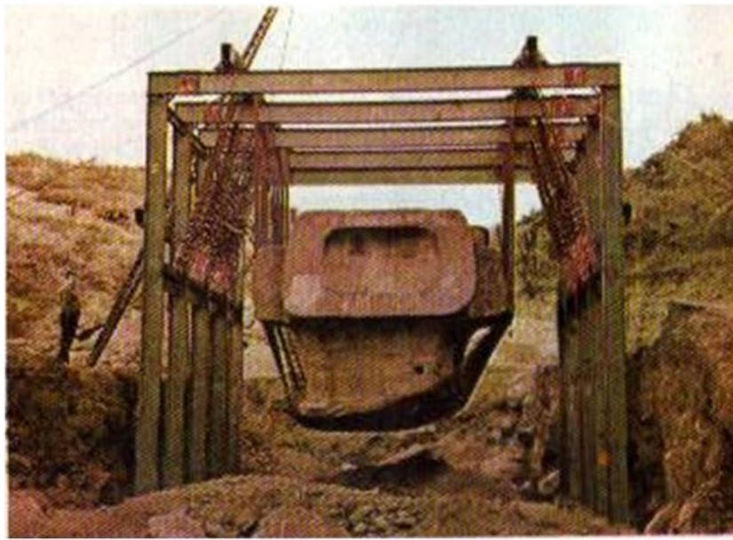
Cables rotos de la estructura que sujetaba la colosal deidad. Foto: libro-folleto, Tláloc el dios de la lluvia , 1994, p. 12.
