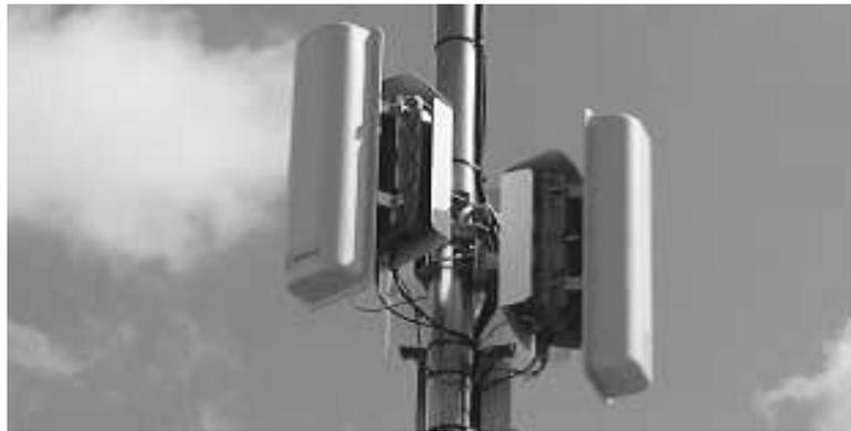
Figura 3.10. Implementación de HiperMAX de Airspan
