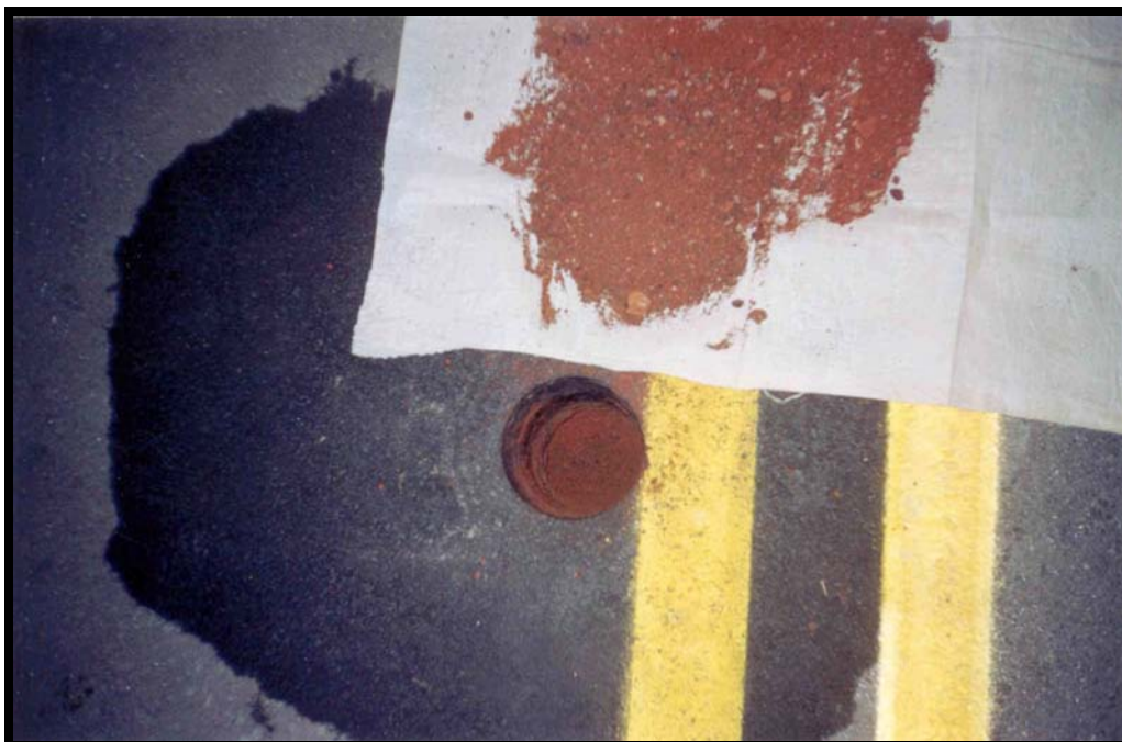
Nótese el material de subbase del sondeo # 6
