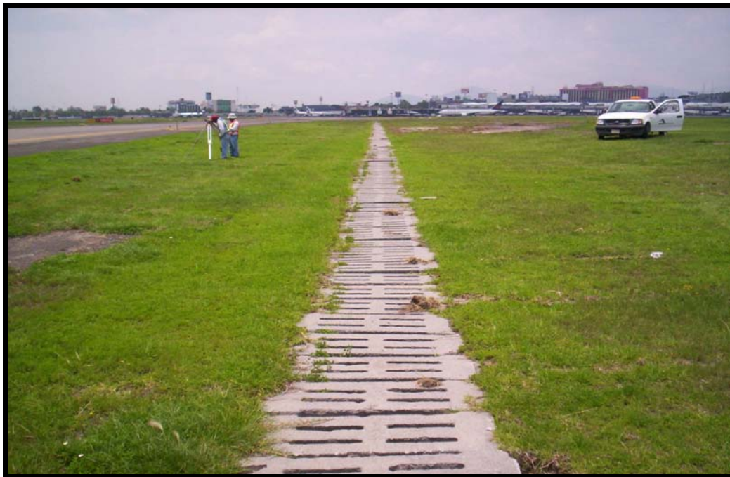
Trinchera para drenaje pluvial ubicada en las cercanías del la Terminal 2.
