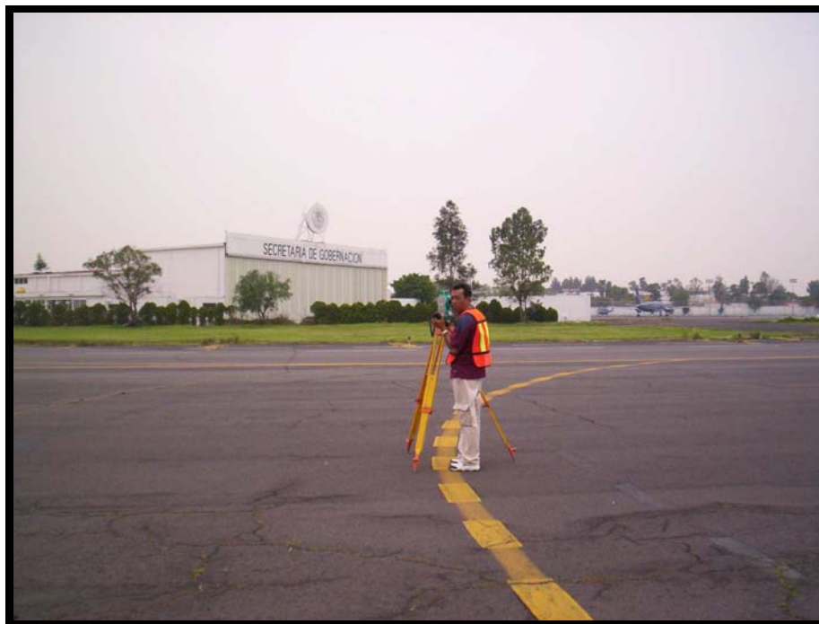
Brigada de Topografía efectuando levantamiento de estructuras existentes.
