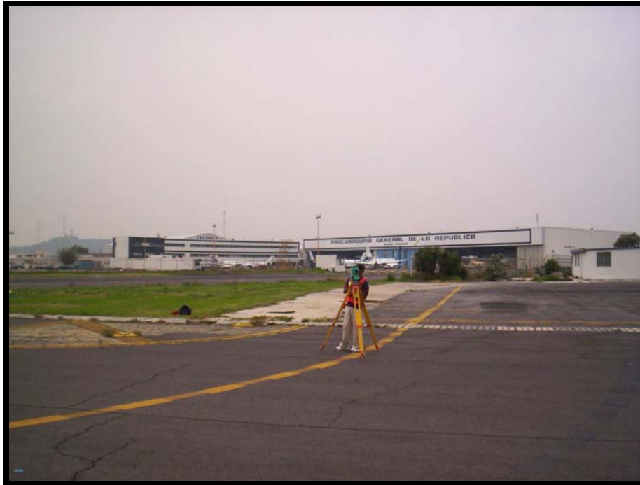
Terminal 2, brigada de topografía efectuando levantamiento.
